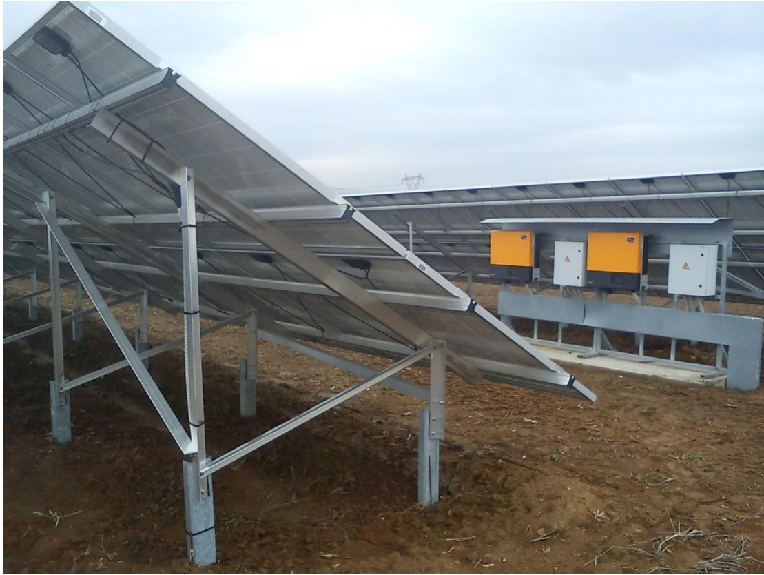
Εικ 3.2.11 Σύστημα στήριξης της Φ/Β συστοιχίας
