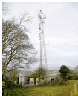
Εικόνα 3.2-6 Vodafone Mast in Nailsworth
