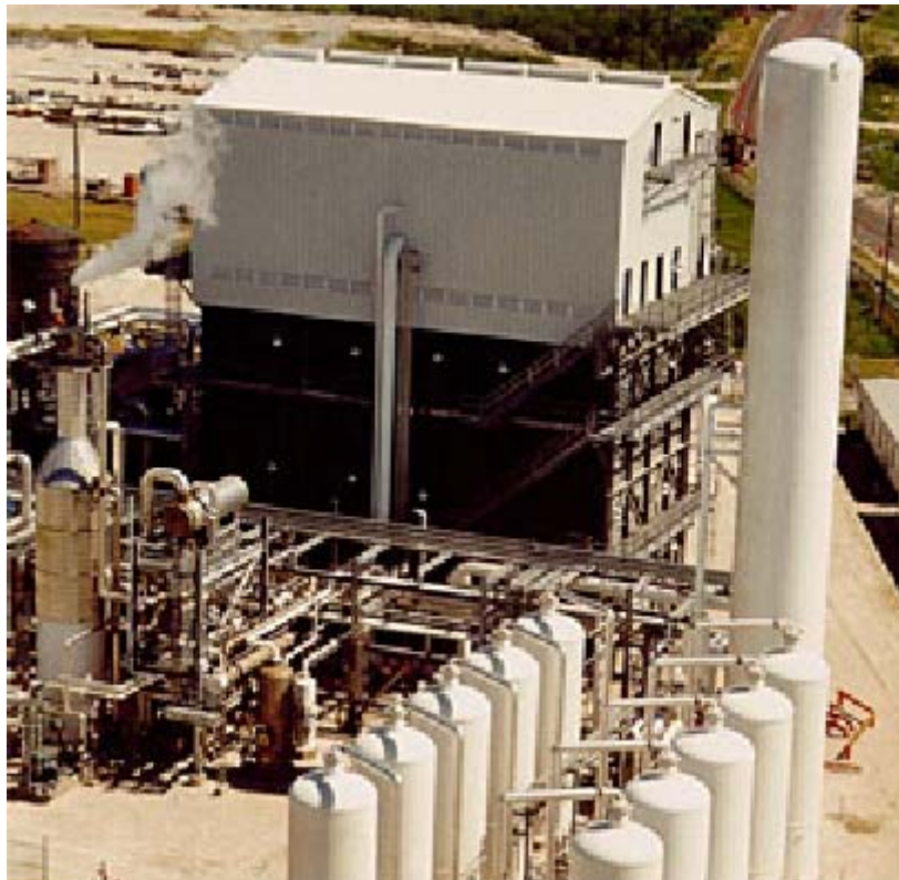
Εγκατάσταση αναμόρφωσης Φυσικού αερίου
