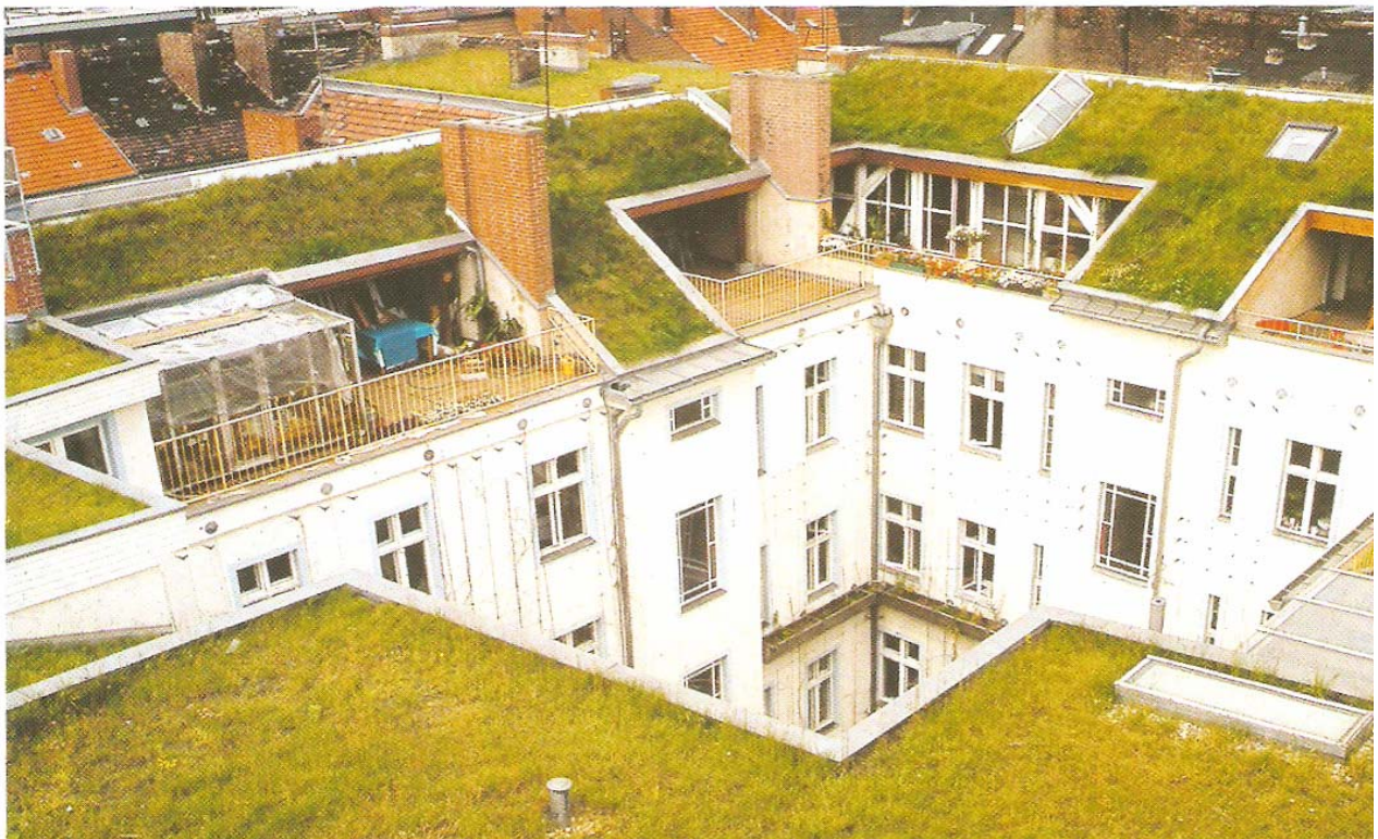
Εικ.9:Κατασκευή στέγης με φύτευση, Berlin-Kreuzberg
