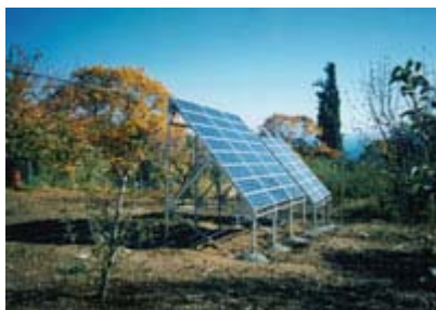
Εικόνα 3.5: Υβριδικό φωτοβολταϊκό σύστημα με Η/Ζ, που ηλεκτροδοτεί Ιερό καλύβι στο Άγιον Όρος
