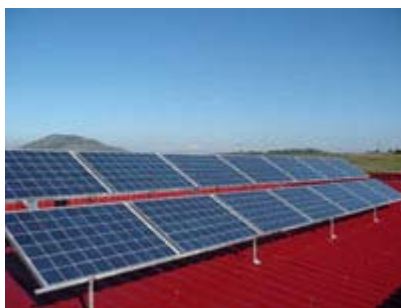
Εικόνα 3:2: Διασυνδεδεμένο σύστημα σε μεταλλική οροφή της εταιρίας STANDOR Ltd. Αυλίδα Εύβοιας, Ιανουάριος 2008
