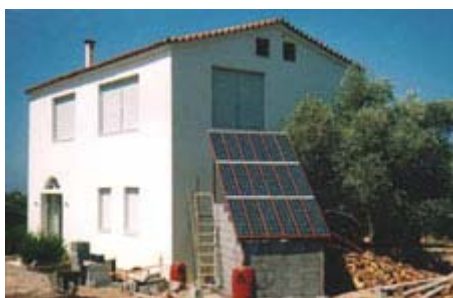
Εικόνα 3.4: Αυτόνομο φωτοβολταϊκό σύστημα σε κατοικία μόνιμης διαμονής στο Ρέθυμνο Κρήτης
