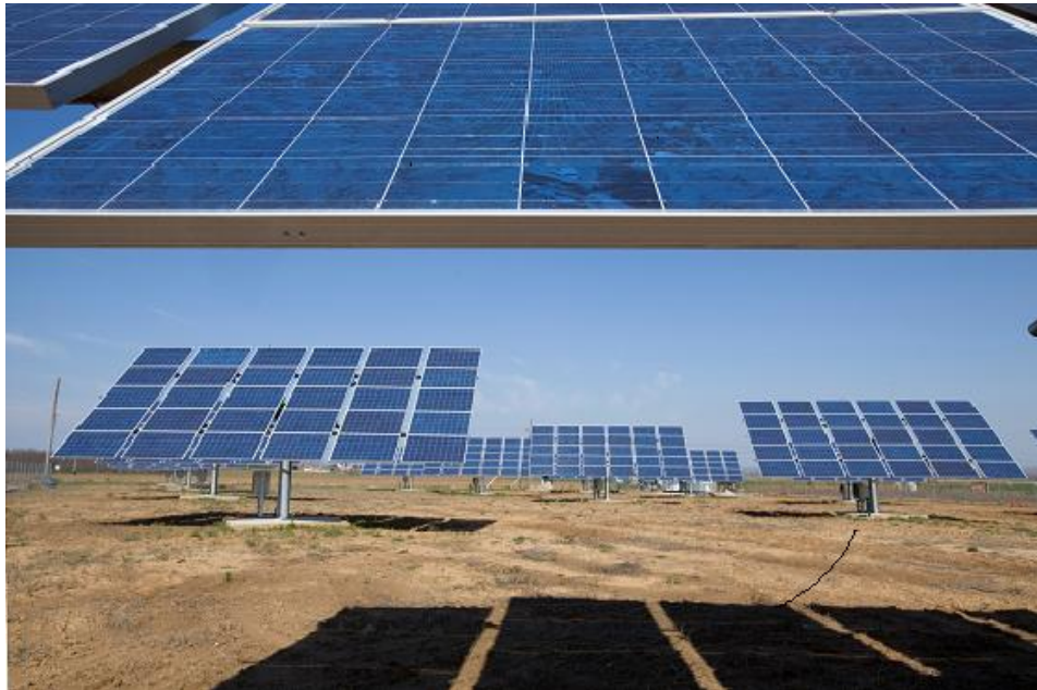
Διατάξεις ιχνηλάτησης της πορείας του ήλιου μονού άξονα
