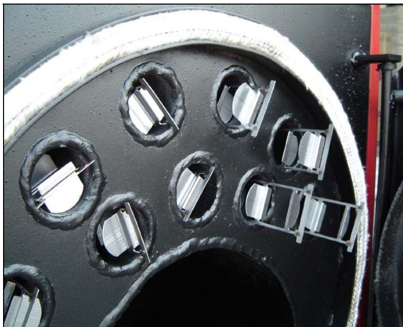
Εικόνα 4.6: ΕΙΔΙΚΟΙ ΣΤΡΟΒΙΛΙΣΤΕΣ ΚΑΥΣΑΕΡΙΩΝ
