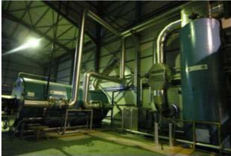
Εικόνα 4.19: ΛΕΒΗΤΑΣ ΔΙΑΘΕΡΜΙΚΟΥ ΕΛΑΙΟΥ 4,5 MW ΜΕ ΚΑΥΣΙΜΟ ΜΑΖΟΥΤ
