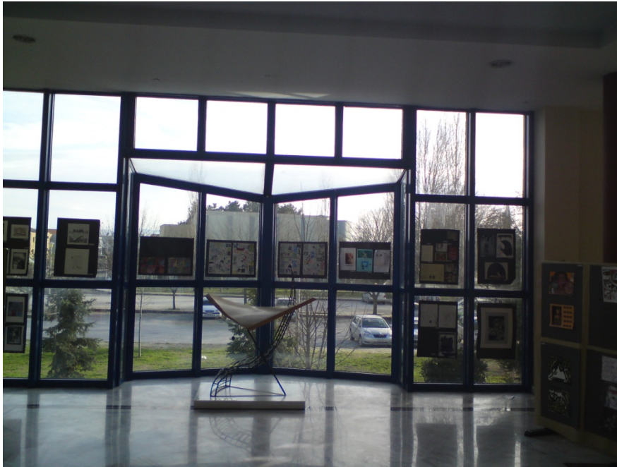
Εικόνα: Εσωτερική όψη του ανοίγματος που θα τοποθετηθεί το παθητικό ηλιακό σύστημα
