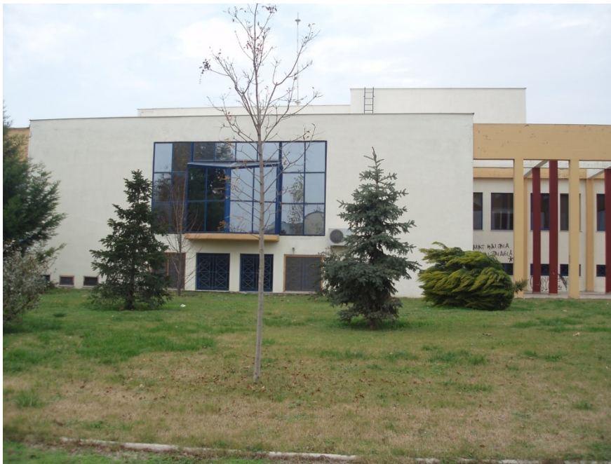
Εικόνα: Εξωτερική όψη του ανοίγματος που θα τοποθετηθεί το παθητικό ηλιακό σύστημα
