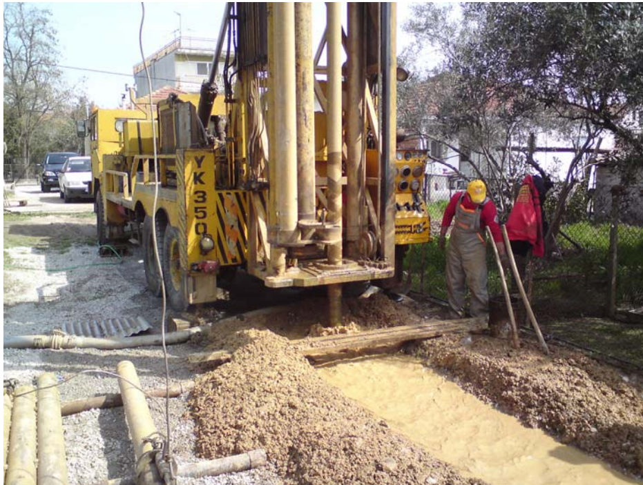
Εικόνα 17: Φωτογραφία από τις γεωτρήσεις κατά την εγκατάσταση της γεωθερμικής αντλίας θερμότητας με κατακόρυφο γεωθεναλλάκτη κλειστού κυκλώματος.
