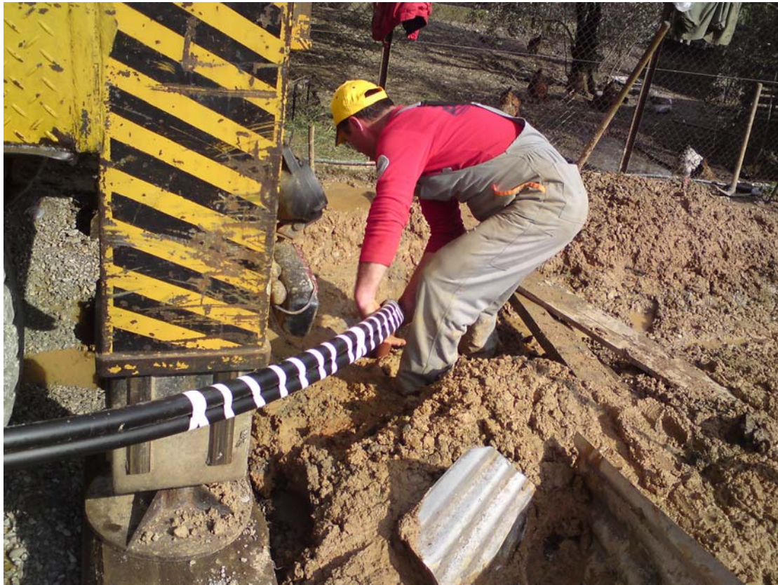
Εικόνα 18: Άλλη φωτογραφία από τις γεωτρήσεις κατά την εγκατάσταση της γεωθερμικής αντλίας θερμότητας με κατακόρυφο γεωεναλλάκτη κλειστού κυκλώματος.
