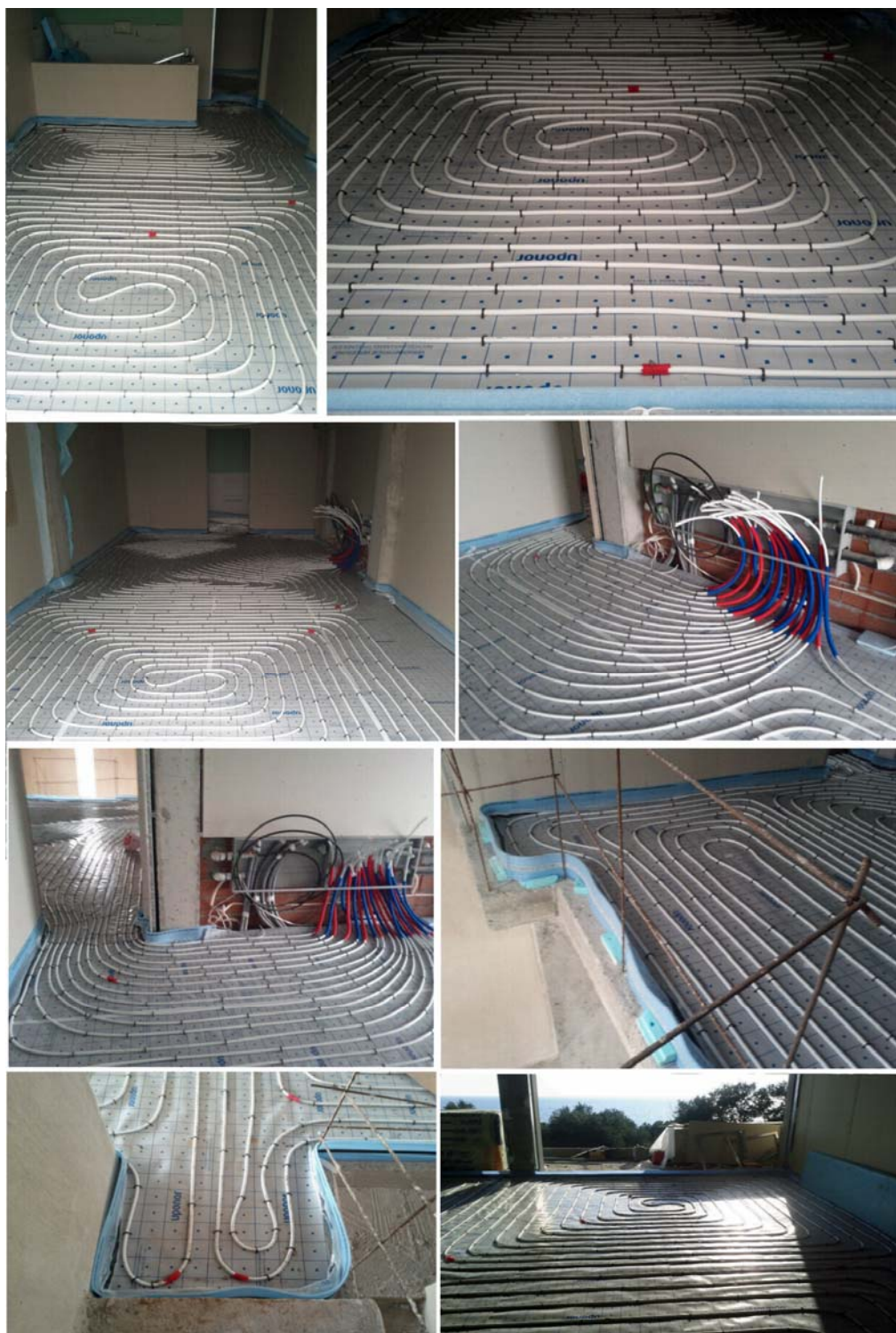
Εικόνα 28: Φωτογραφίες από την εγκατάσταση σωληνώσεων ενδοδαπέδιας θέρμανσης με αβαθή γεωθερμία στην διώροφη κατοικία στα Μουδανιά.
