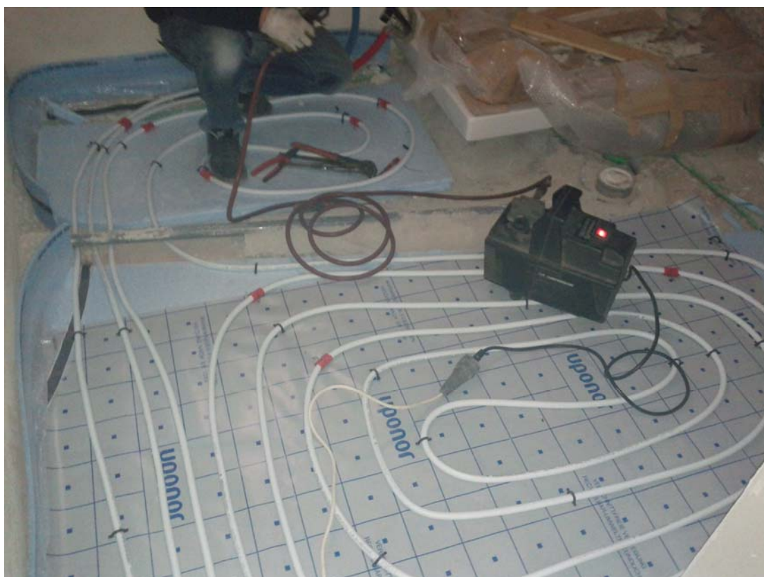
Εικόνα 34: Η δοκιμή πίεσης των σωληνώσεων της εγκατάστασης ενδοδαπέδιας θέρμανσης με την βοήθεια κομπρεσέρ αέρα. (Κατοικία στα Μουδανιά Χαλκιδικής).
