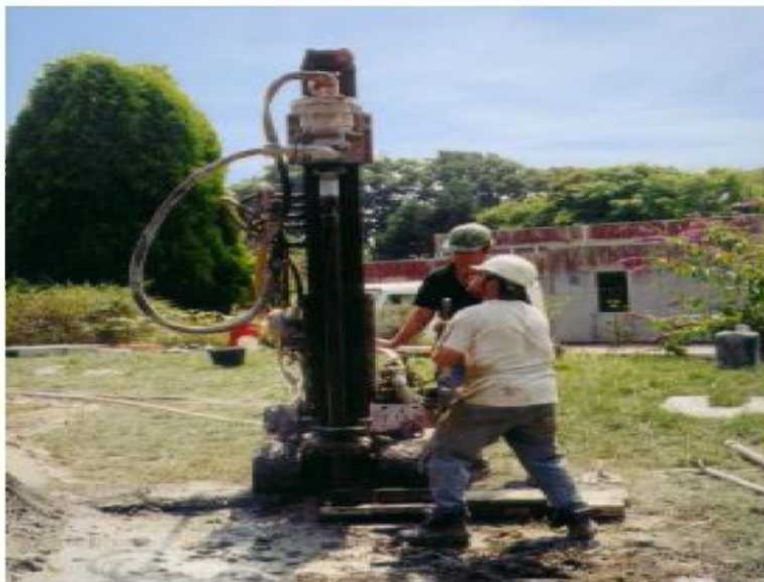
Γεωτρύπανο για τη διάνοιξη Γεώτρησης
