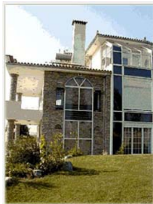
Εικόνα 1: Παθητικό ηλιακό σύστημα
