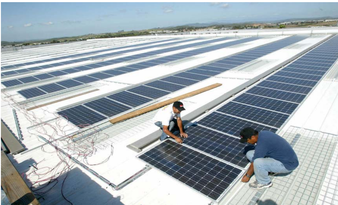
Εικόνα 9 : Ηλιακό σύστημα 25 KW – 250 m 2 – 25000 KWh ανά έτος
