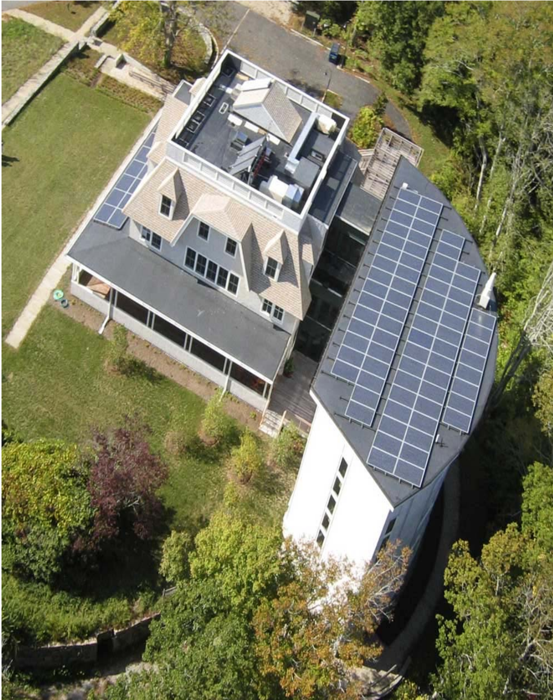
Εικόνα 3 : Ηλιακοί συλλέκτες τοποθετημένοι σε ταράτσα κτιρίου στο Ανόβερο της Γερμανίας
