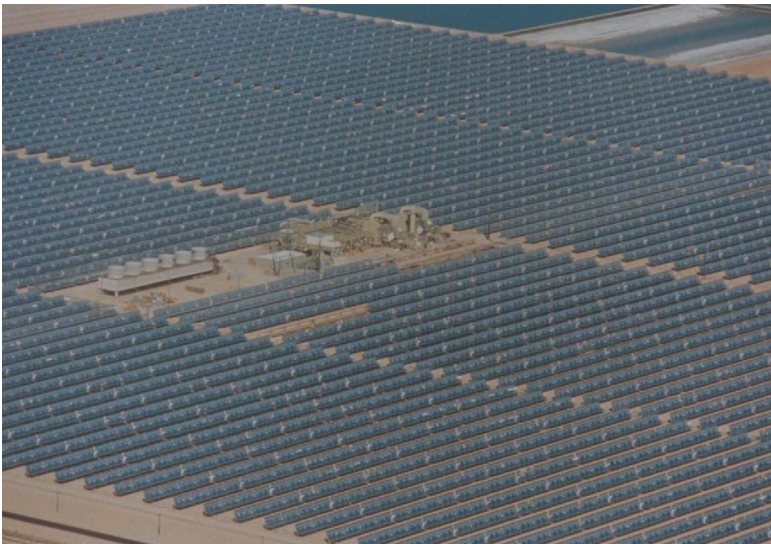
Εικόνα 7 : Μονάδα παραγωγής ηλεκτρικής ενέργειας
