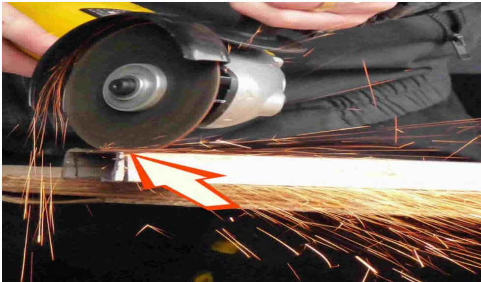
Εικόνα 15 : Διαδικασία κοπής με δίσκο
