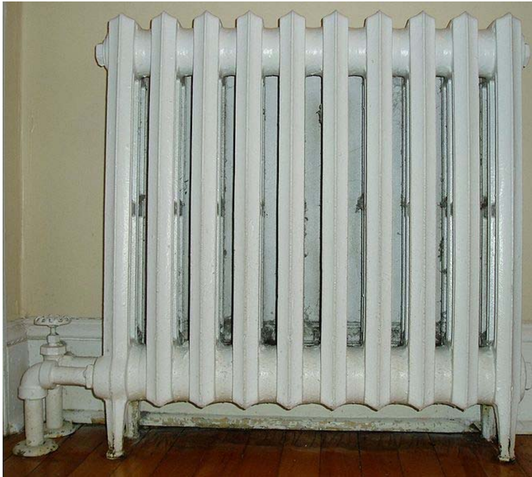
Παλιό θερμαντικό σώμα («καλοριφέρ») φτιαγμένο από χυτοσίδηρο («μαντέμι»).
