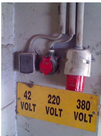
3.6 : Πρίζες τάσεις 42 Volt, 220 Volt και των 380 Volt που πρέπει να υπάρχουν στο χώρο.
