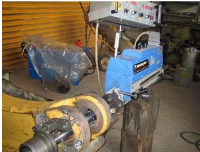
2.30 : Απο την επισκευή μπράτσου λαστιχοφόρου φορτωτή.
