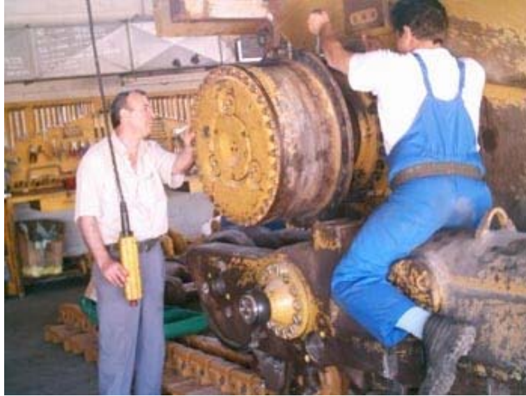
2.29 : Από την τοποθέτηση τελικής κίνησης σε προωθητήρια D8L.
