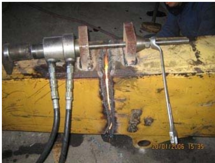
2.34 : Επισκευή σε κομμένο μπαστούνι CAT 229.
