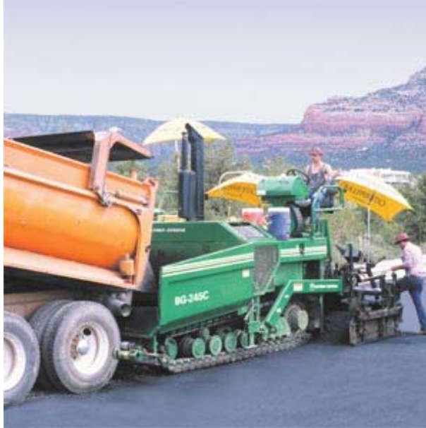
1.8 : Μηχάνημα παραγωγής και επίστρωσης ασφαλτομίγματος.
