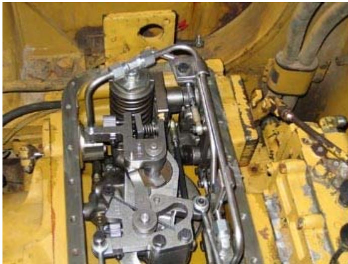
2.26 : Από την επισκευή υδροστατικού συστήματος μετάδοσης κίνησης.
