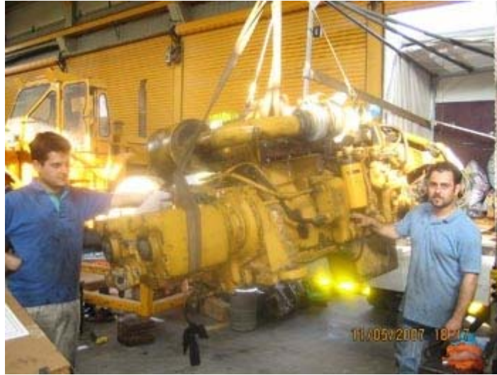
2.18 : Κινητήρας μετά την επισκευή του κατά την φόρτωση του.
