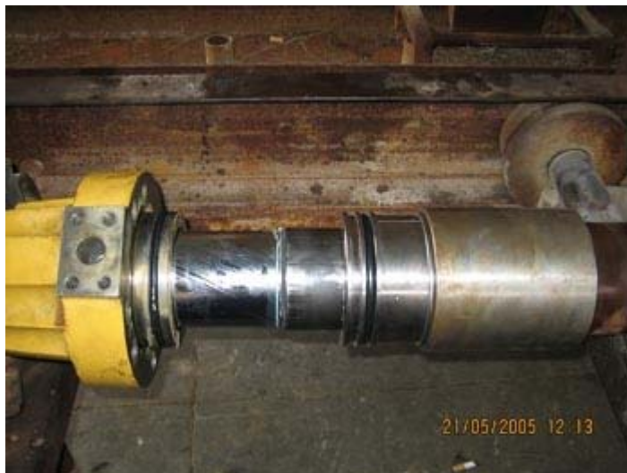
2.43 : Από επισκευή υδραυλικού κυλίνδρου εκσκαφέα.
