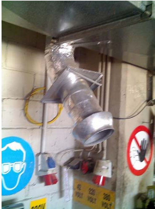
3.3 : Ειδική αναμονή που συνδέεται με εύκαμπτο σωλήνα επαγωγής καυσαερίων.
