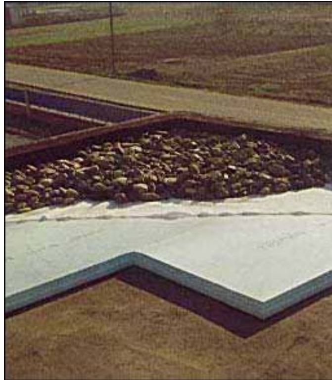
Εικόνα 1.7: Παράδειγμα μόνωσης οροφής σε υφιστάμενο κτίριο.
