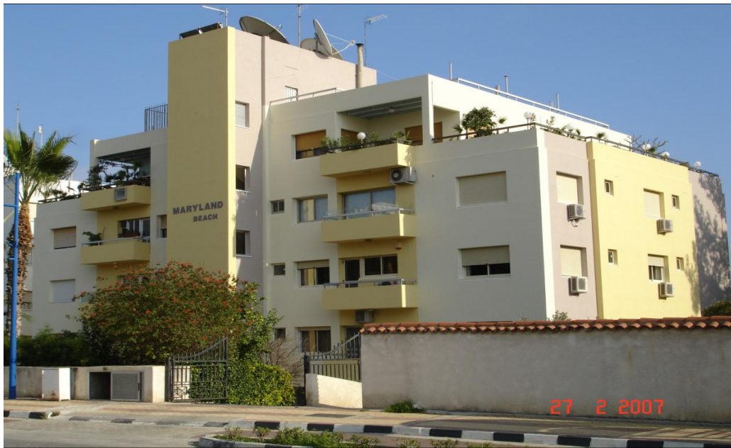
Εικόνα 4.1 : Εξωτερική άποψη ενός κτιρίου προτού την θερμομόνωση.(πηγή ΚΝΑUF)
