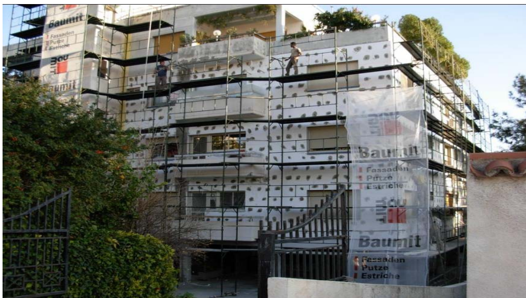
Εικόνα 4.2 : Τοποθέτηση μόνωσης σε εξωτερικούς τοίχους.(πηγή KNAUF)
