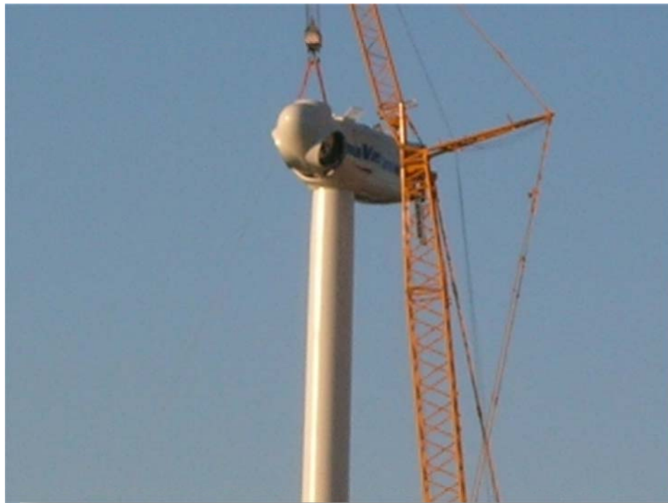
Ρότορας κατά τη φάση της άνεγερσης και τοποθέτησης στην άτρακτο της ανεμογεννήτριας.
