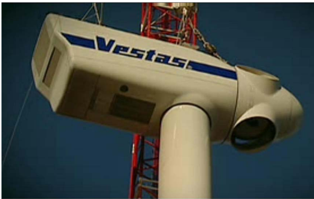
Η άτρακτος τοποθετημένη στην κορυφή του χαλύβδινου πύργου
