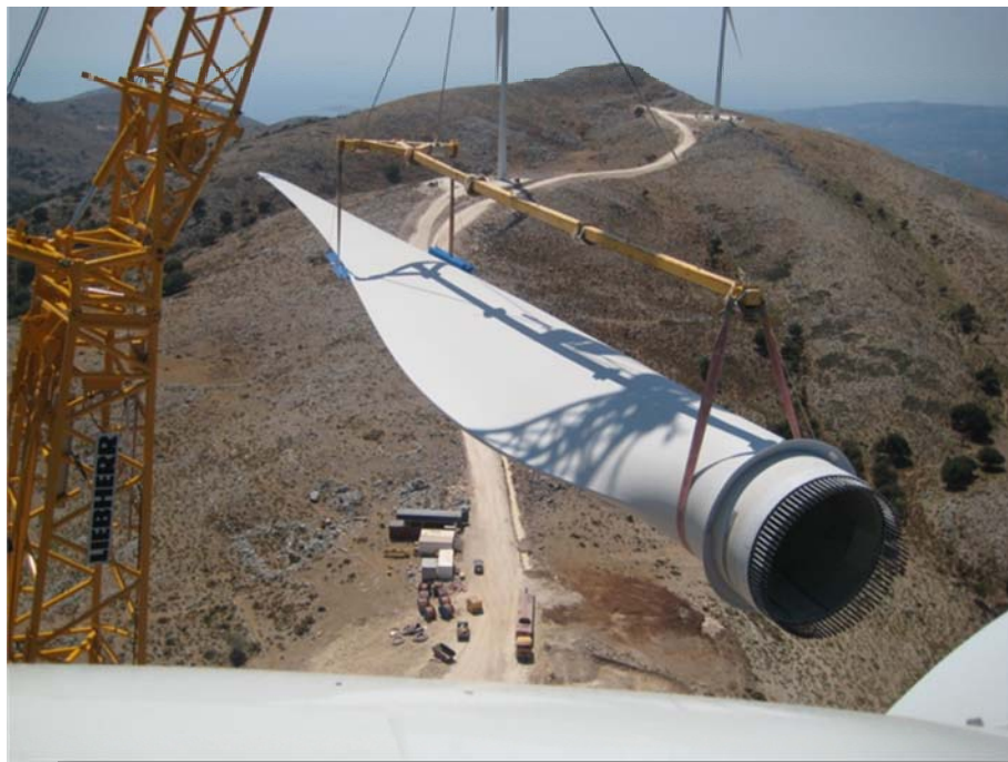
Πτερύγιο πολύ κοντά στο σημείο σύνδεσης με τον ρότορα
