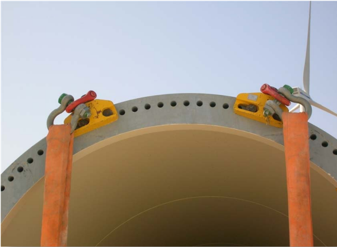
Τοποθέτηση ανυψωτικών στην φλάντζα της βάσης κάθε τμήματος
