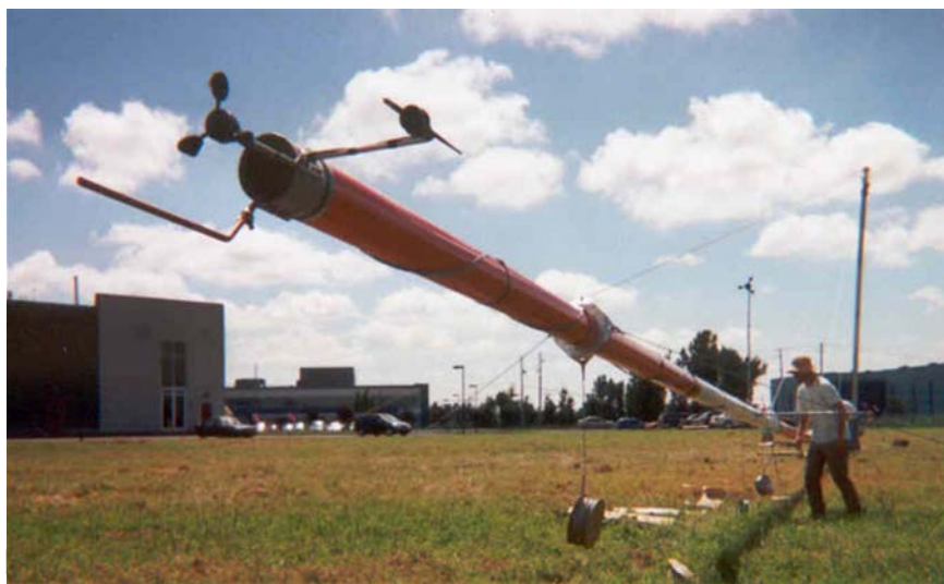
Εγκατάσταση μετεωρολογικού ιστού
