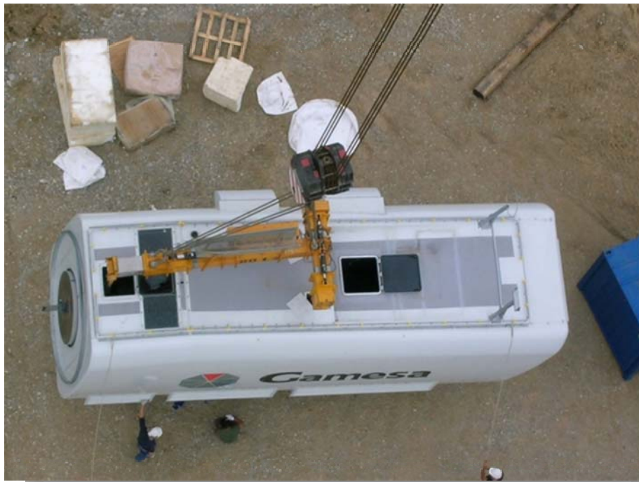
Τοποθέτηση ανυψωτικών συσκευών σε άτρακτο της εταιρείας Gamesa
