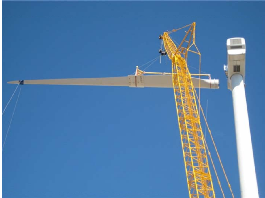
Πτερύγιο κατά τη φάση της ανύψωσης, λίγο πριν τοποθετηθεί στον ρότορα.
