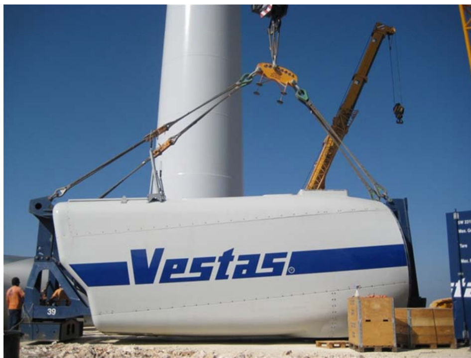
Τοποθέτηση ανυψωτικών συσκευών σε άτρακτο της εταιρείας Vestas
