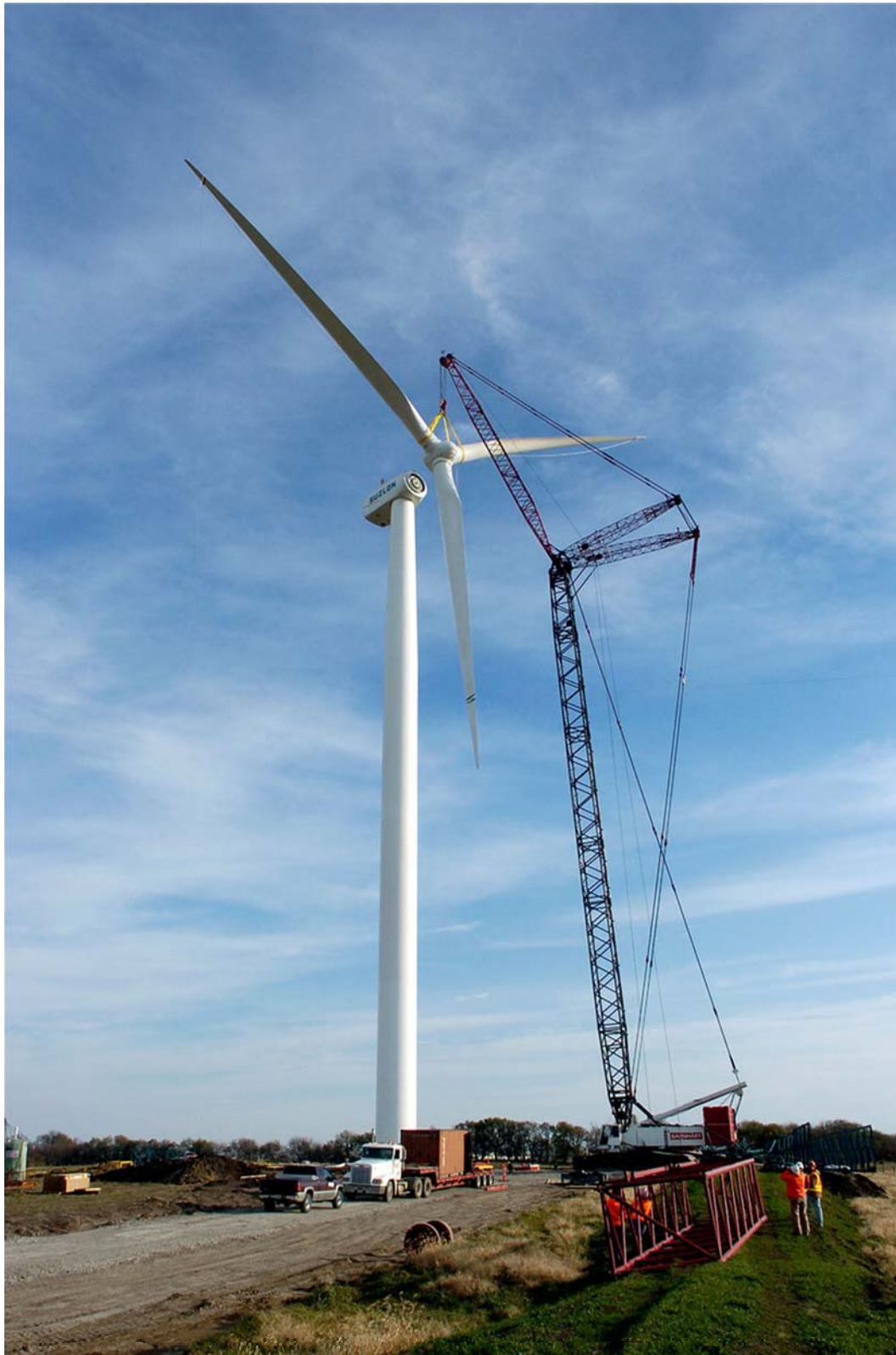
Ανέγερση ρότορα ανεμογεννήτριας με τα περύγια συναρμολογημένα στο έδαφος.
