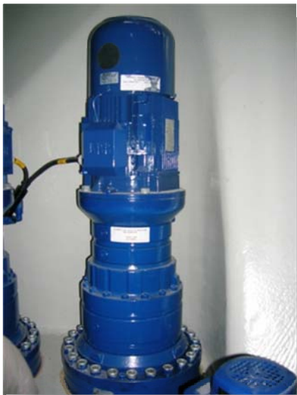
Η λεκτροκινητήρας με γρανάξι εγκατεστημένος στην οδοντωτή στεφάνη ανεμογεννήτριας
