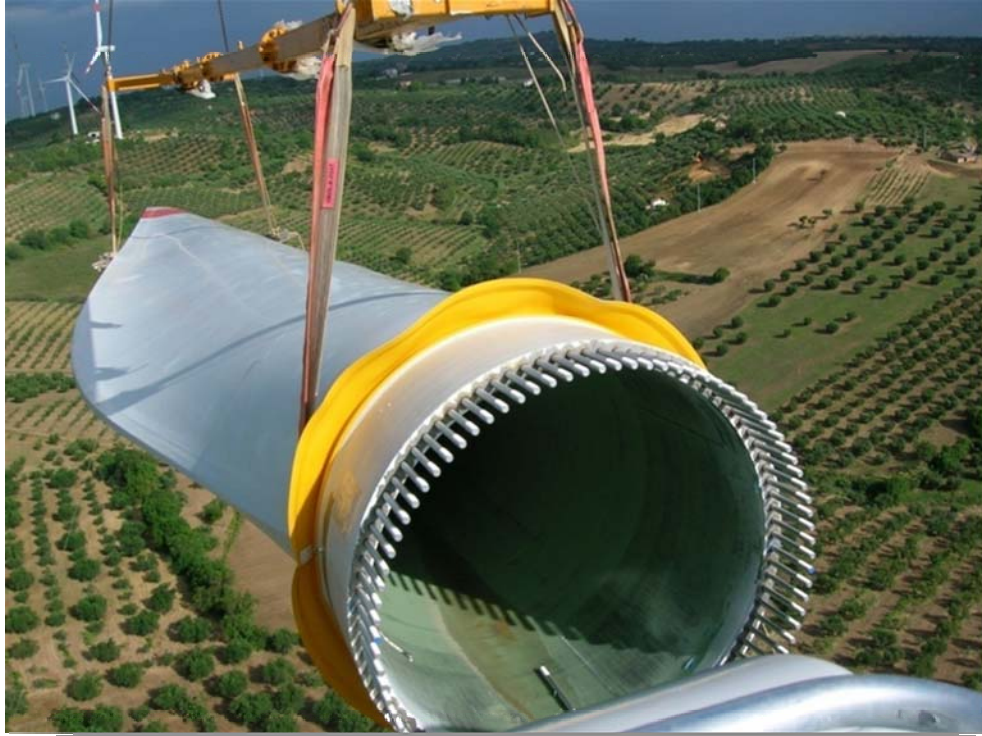
Πτερυγίο που τοποθετείται σε ένα από τα τρία όμοια τμήματα του ρότορα.
