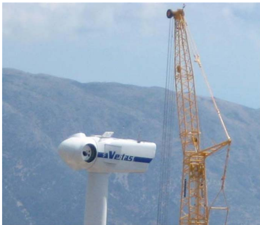
Ρότορας τοποθετημένος στην άτρακτο της ανεμογεννήτριας.
