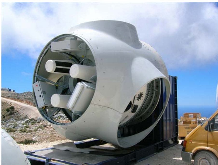
Ρότορας ανεμογεννήτριας κατά τη φάση της συναρμολόγησης στο έδαφος. (2)
