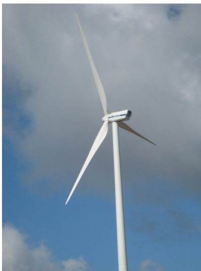
Σωληνωτός χαλύβδινος πύργος
