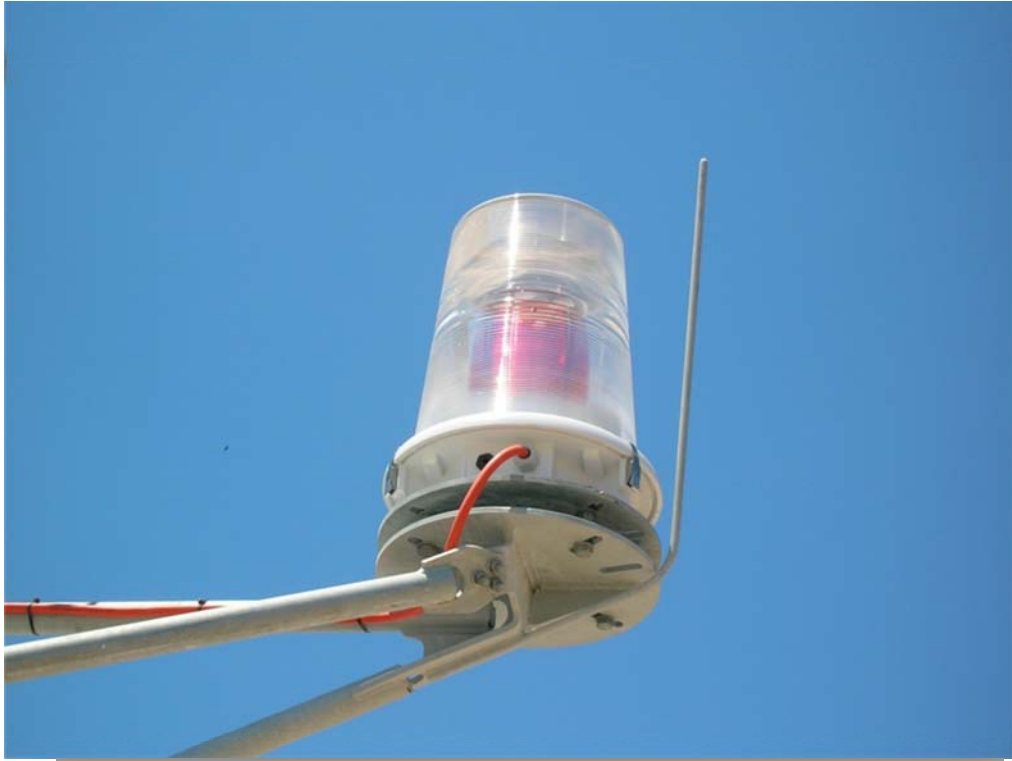
Φάρος σύγχρονης ανεμογεννήτριας ( Vestas V90-3MW )
