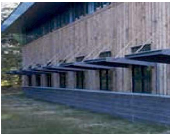
Εικόνα 88. Εξωτερικά ράφια φωτισμού
