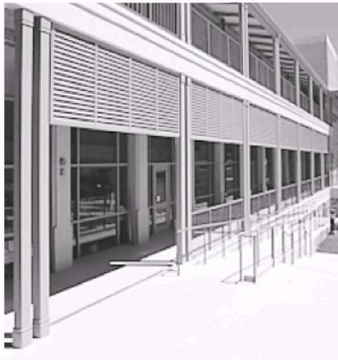
Εικόνα 44: Διάταξη από κάθετες, σταθερές, εξωτερικές περσίδες, κατάλληλες για ανατολικό και δυτικό προσανατολισμό [66]
