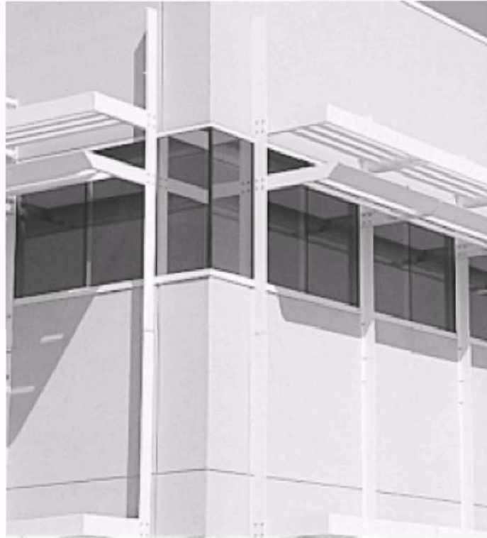
Εικόνα 43: Οριζόντιες εξωτερικές περσίδες, κατάλληλες για νότιο προσανατολισμό. Λειτουργούν αποδοτικά, εκτός από τις γωνίες. Διπλή σειρά περσίδων έχει χρησιμοποιηθεί [66]
