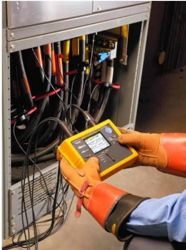
Εικόνα 4.9 Ενεργειακός αναλυτής Fluke power logger 1735 σε συνδεσμολογία με τις 3 φάσεις
