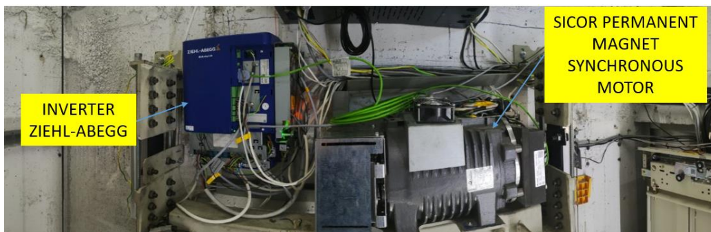
Εικόνα 4.10 Πειραματική διάταξη στο φρεάτιο ανελκυστήρα
