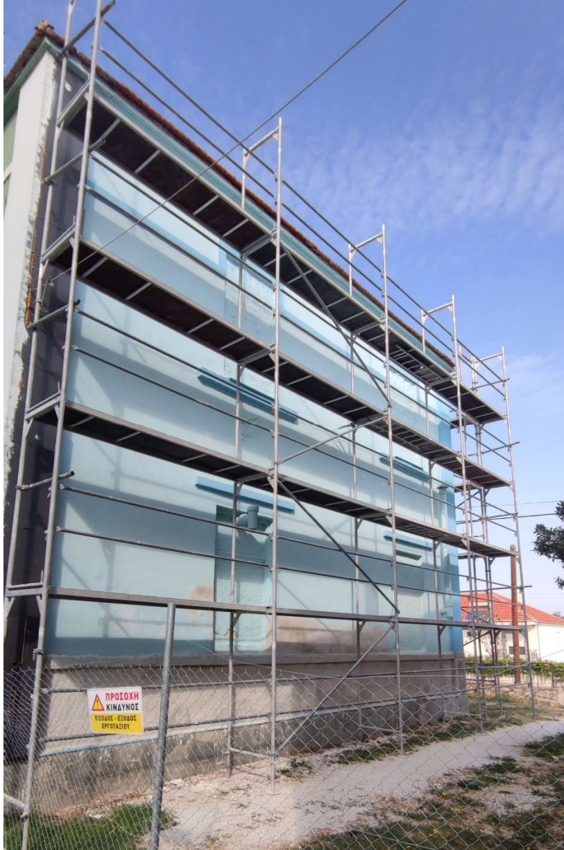
Εικόνα: Δεξιά πλάγια όψη κτιρίου
