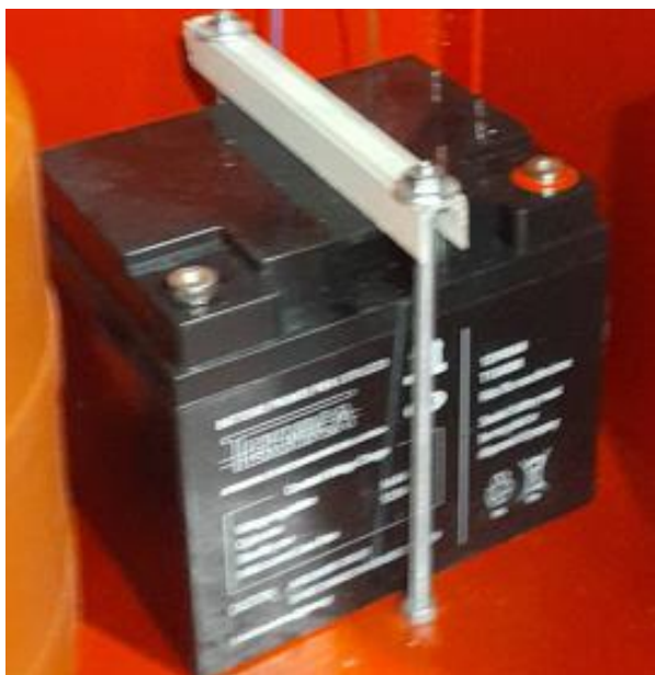
Εικόνα 16: Σταθεροποίηση συσσωρευτή
