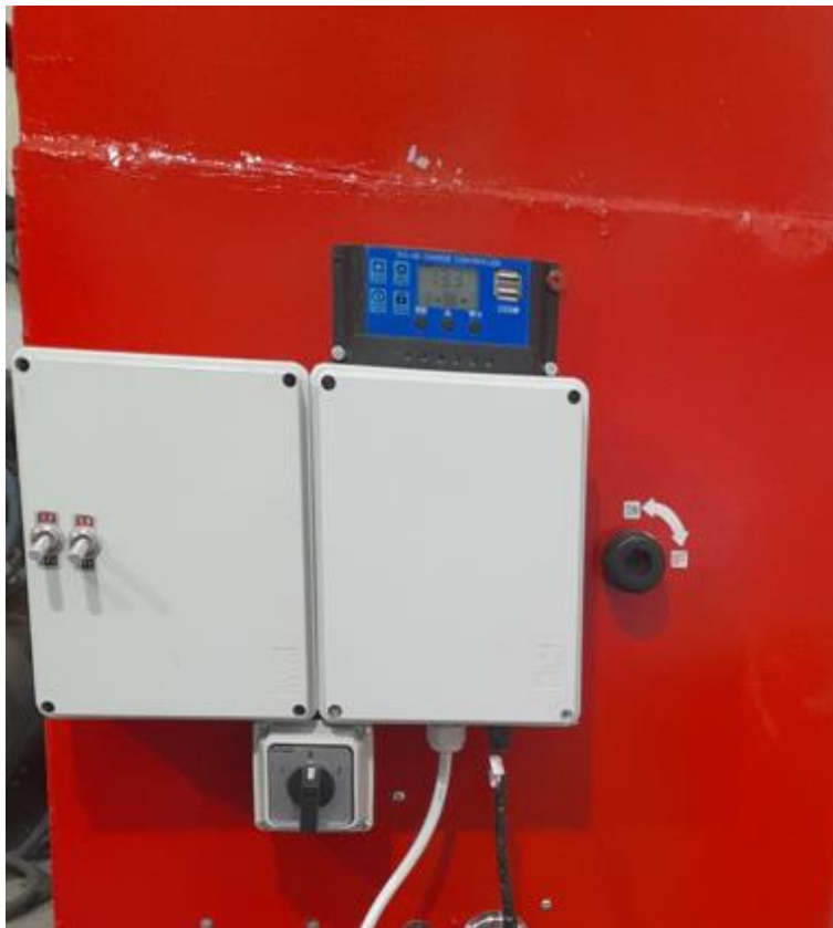
Εικόνα 23: Τοποθετημένα το πλαστικό κουτί και ρυθμιστής φόρτισης και περιστροφικός διακόπτης.
