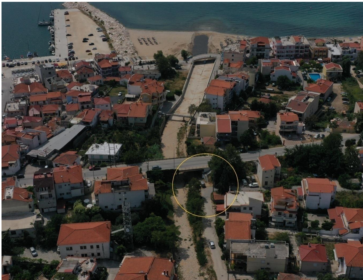
Εικόνα 5.6 Παρκαρισμένα αμάξια στην κοίτη του ρέματος και σπίτια χτισμένα πολύ κοντά στο ρέμα.
