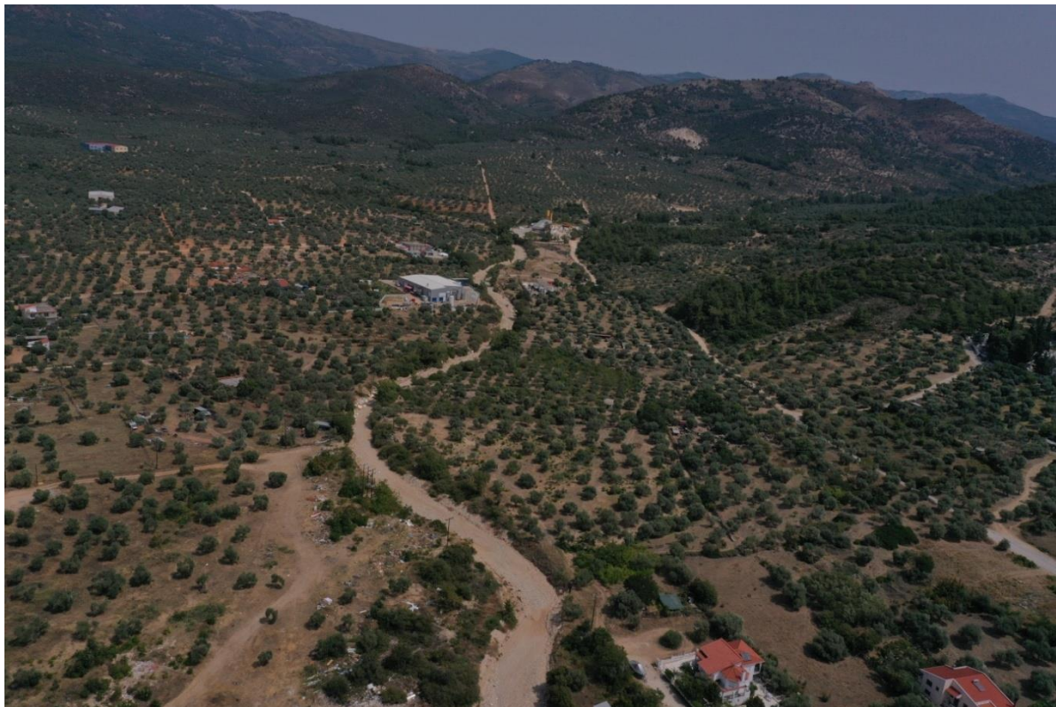
Εικόνα 5.7 Η κατάσταση του ρέματος κοντά στον οικισμό
