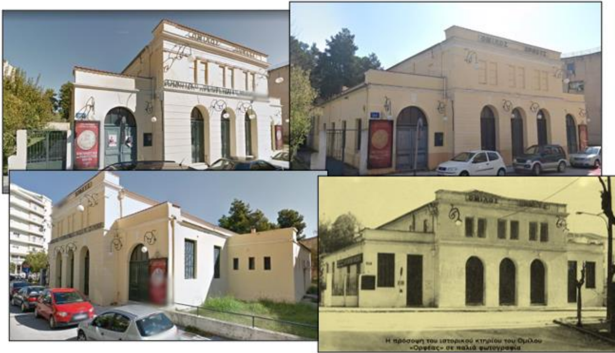
Εικόνα 22:(α) Πρόσοψη κτίσματος από την οδό Ορφέως (πηγή: Googlemaps), (β) πρόσοψη από την διασταύρωση των οδών Ορφέως και Εθν. Αντιστάσεως (πηγή: Googlemaps), (γ) πλάγια όψη κτίσματος από την οδό Ορφέως (πηγή: Googlemaps) και (δ) πρόσοψη του ιστορικού κτιρίου περί το 1950 (πηγή: επίσημο γκρουπ facebook “Όμιλος Ορφέας Σερρών”).
