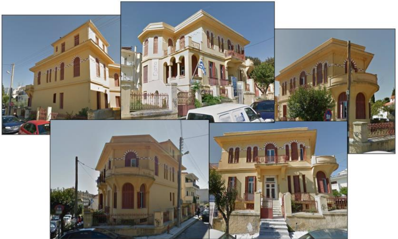
Εικόνα 19.: (α) Όψη κτιρίου από την οδό Ακροπόλεως, (β) από την οδό Ν. Φωκά, (γ) και (δ) από την συμβολή των οδών και (ε) η είσοδος του κτιρίου επί της οδού Ν. Φωκά (πηγή: Googlemaps).
