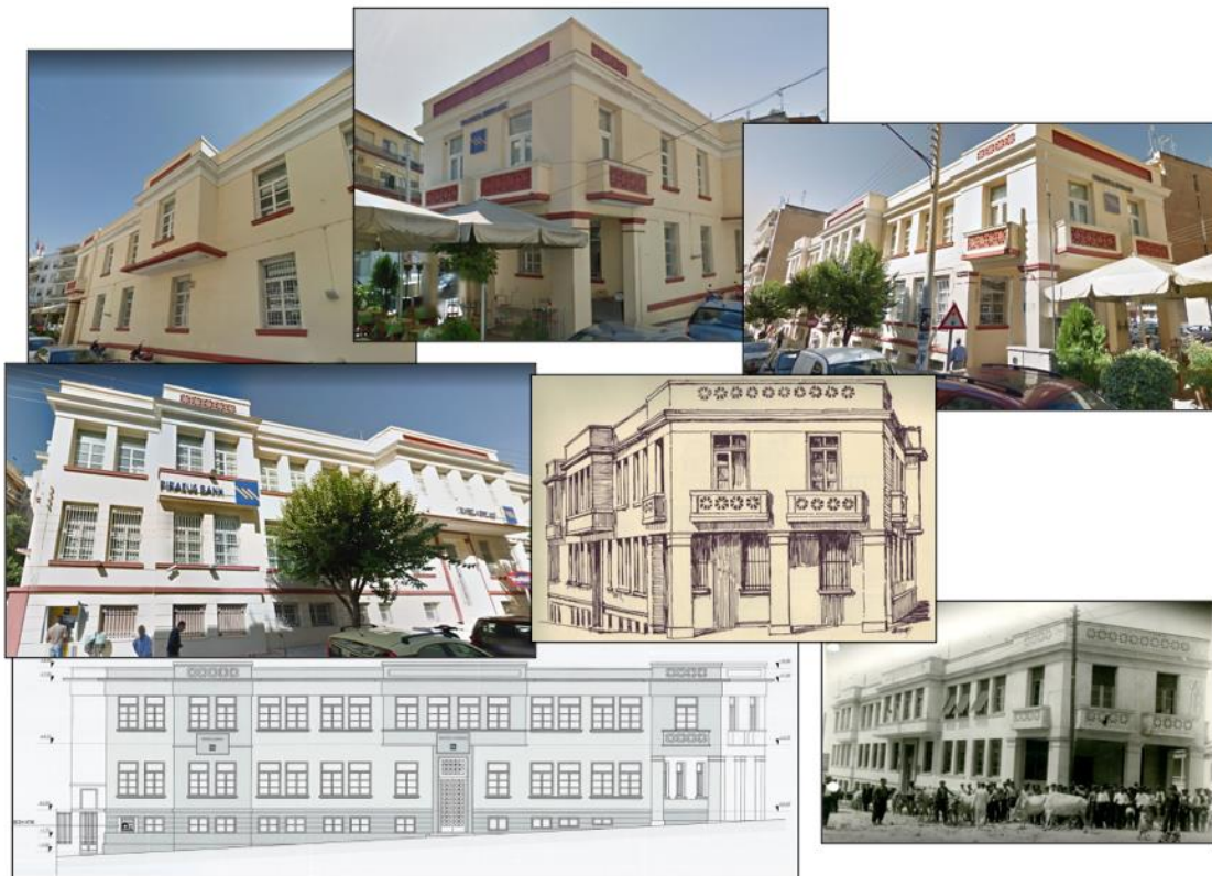
Εικόνα 31:(α) και (β) Όψη από οδό Γρ. Ρακιντζή (πηγή: Googlemaps), (γ) και (δ) όψη της κύριας οδού από την οδό Νικ. Πλαστήρα (πηγή: Googlemaps), (ε) Αγροτική Τράπεζα (έργο του Χρ. Μελλίδη), (στ) Όψη κτιρίου επί της Νικ. Πλαστήρα (πηγή: Αρχείο Τμ. Μελετών Τρ. Πειραιώς), (ζ) Πλευρική άποψη κτίσματος το 1935 (serfree.gr).
