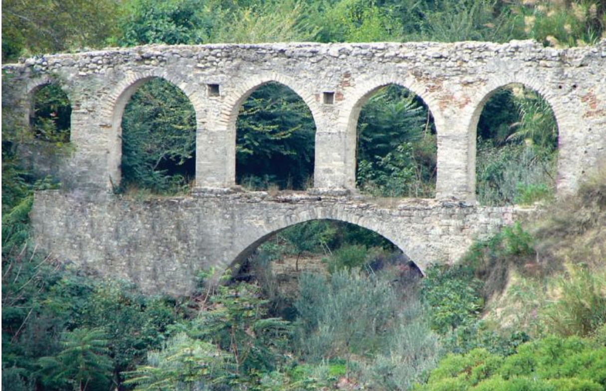
Σχήμα 2.4. Η υδρογέφυρα του Λόφου Μουσάλα όπως υπάρχει σήμερα
