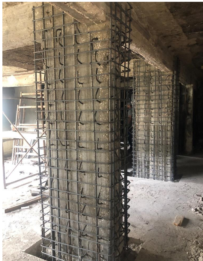
Εικόνα 11: Διάτρηση πλάκας πυλωτής και τοποθέτηση διαμήκους οπλισμού υποστυλωμάτων, πηγή: ίδια επεξεργασία
