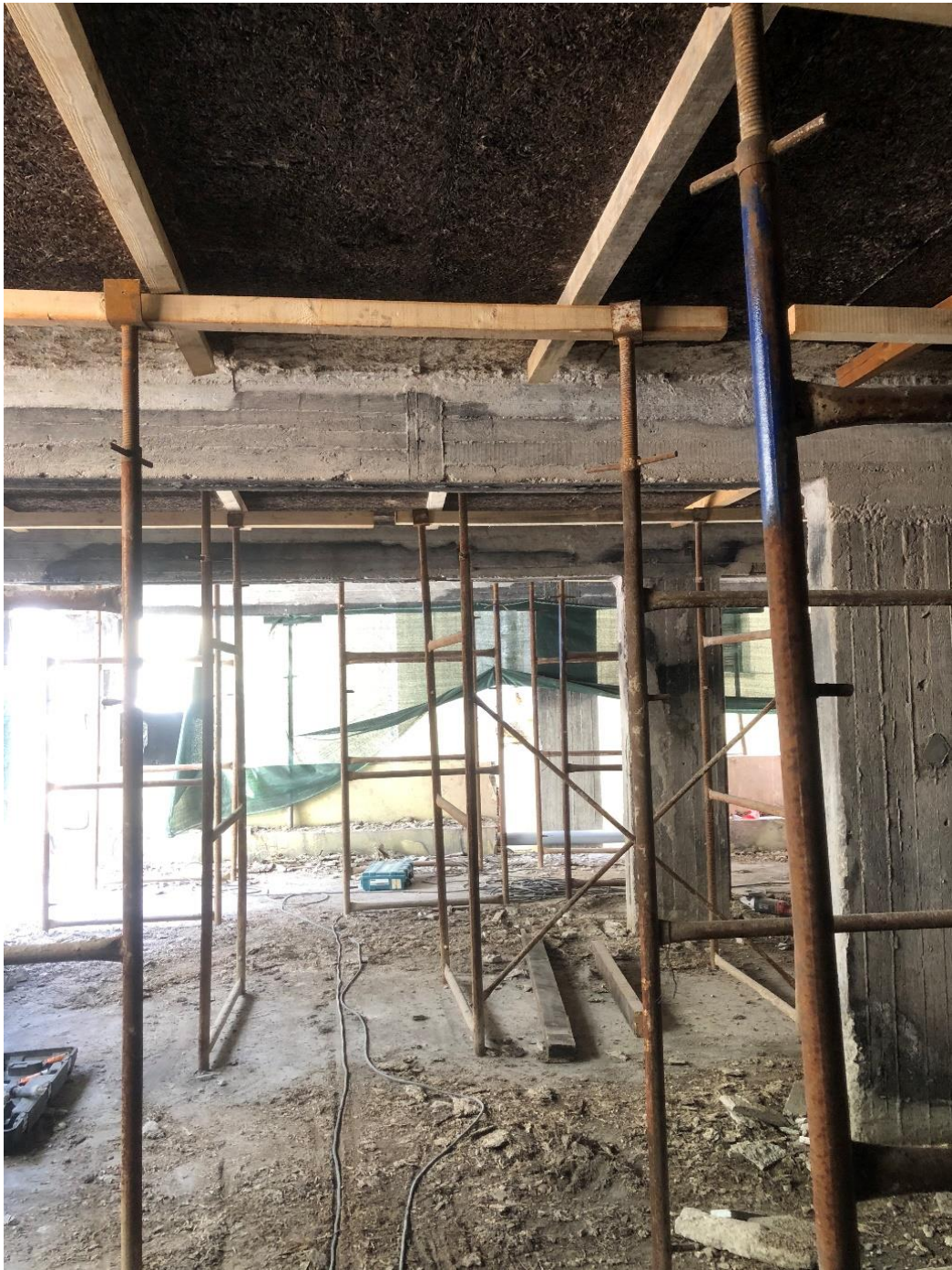
Εικόνα 9: Υποσύλωση φορέα με ικριώματα
