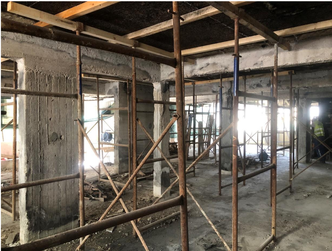
Εικόνα 9: Τοποθέτηση κριωμάτων βαρέως τύπου, πηγή: ίδια επεξεργασία
