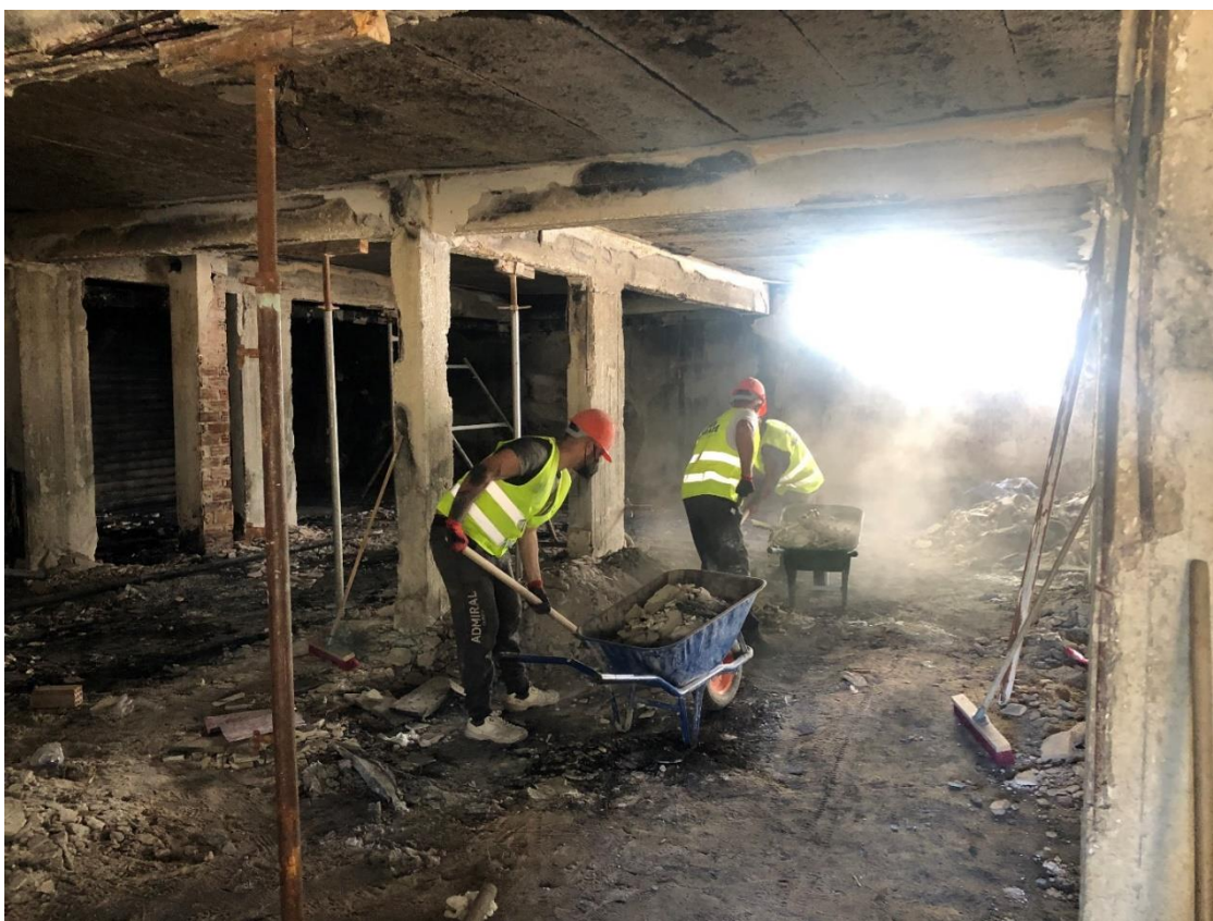
Εικόνα 8: Καθαρισμός πυλωτής από αποκολλημένα επιχρίσματα και σκυρόδεμα
