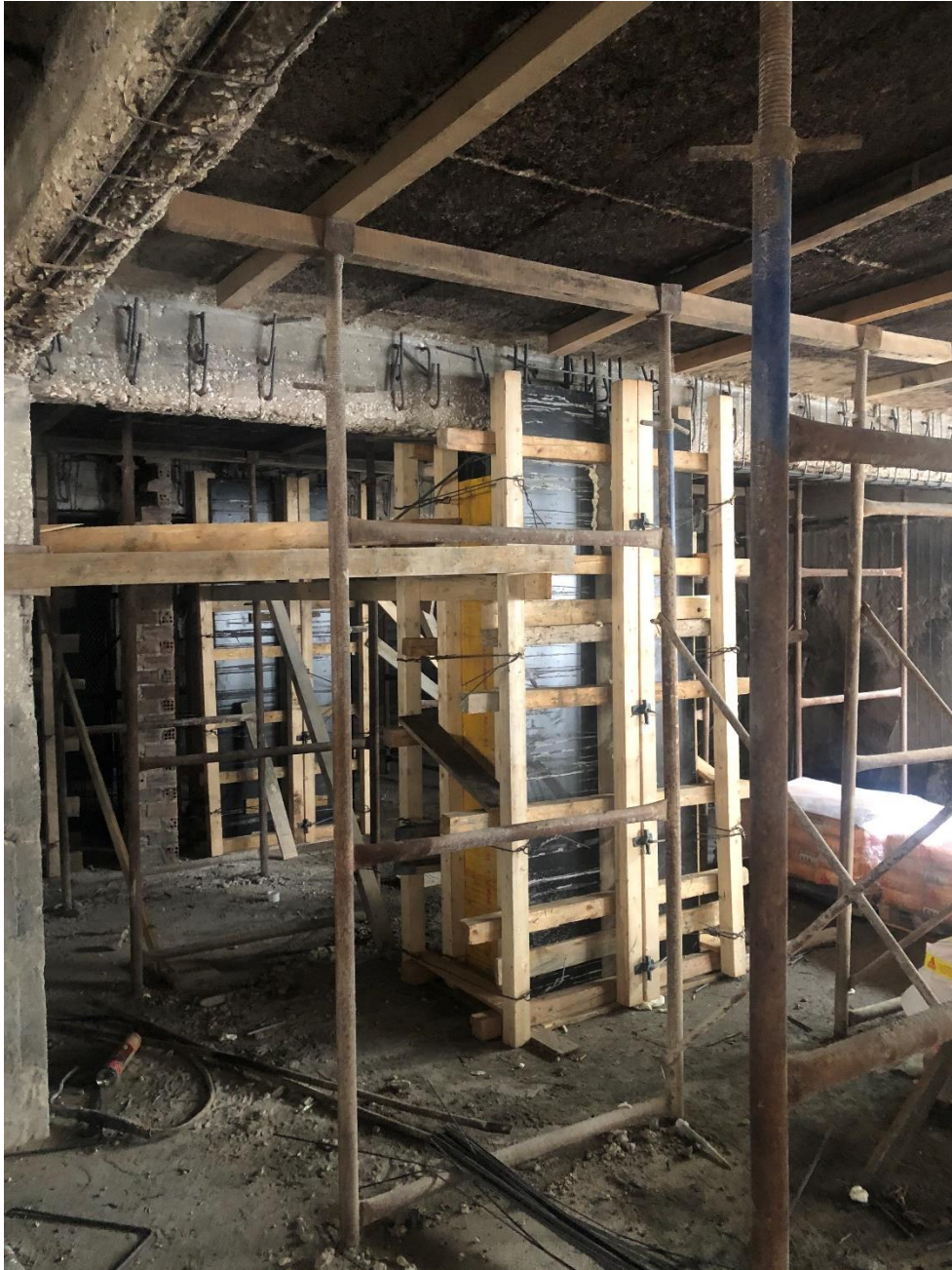
Εικόνα 10: Καθαίρεση επικάλυψης βλαμένου σκυροδέματος σε δοκούς, πηγή: ιδία επεξεργασία
