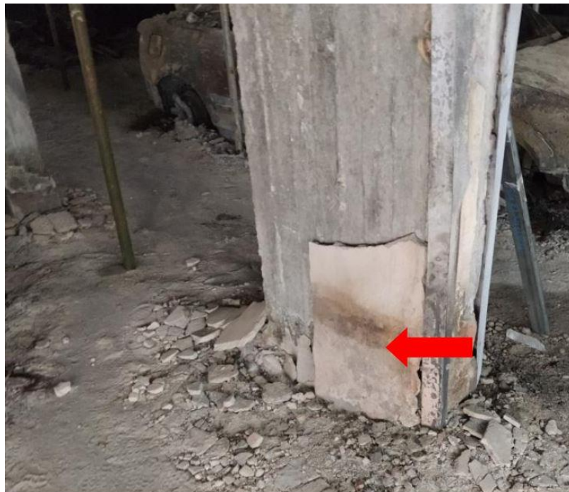
Εικόνα 7: Επίχρισμα που διατηρήθηκε, πηγή: ίδια επεξεργασία
