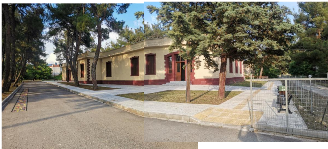
Εικόνα 3.23: Άποψη του κτηρίου Κ1 που αποκαταστάθηκε και σήμερα λειτουργεί ως Μουσείο Σύγχρονης Τέχνης Κων. Ξενάκη/πηγή: προσωπικό αρχείο
