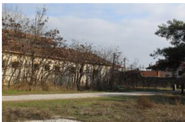
Εικόνα 4.7: Κτήριο αποθηκών ορθογωνικής κάτοψης πηγή : προσωπικό αρχείο
