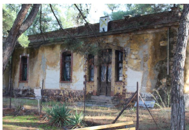
Εικόνα 4.6: το κτήριο διοίκησης/πηγή : προσωπικό αρχείο
