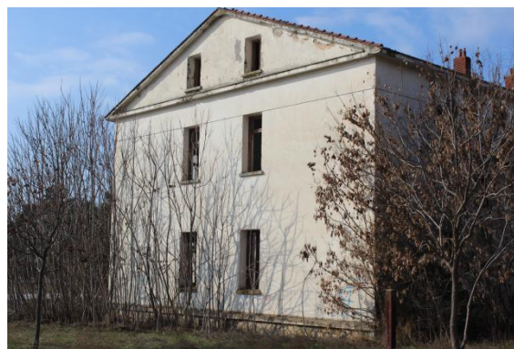
Εικόνα 4.4: Ανατολική όψη του κτηρίου στρατωνισμού/πηγή: προσωπικό αρχείο
