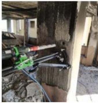
Εικόνα 4.9 Λήψη πυρήνα από τοίχιο
