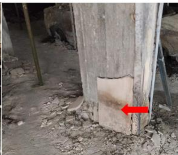
Εικόνα 4.2 Επίχρισμα που διατηρήθηκε
