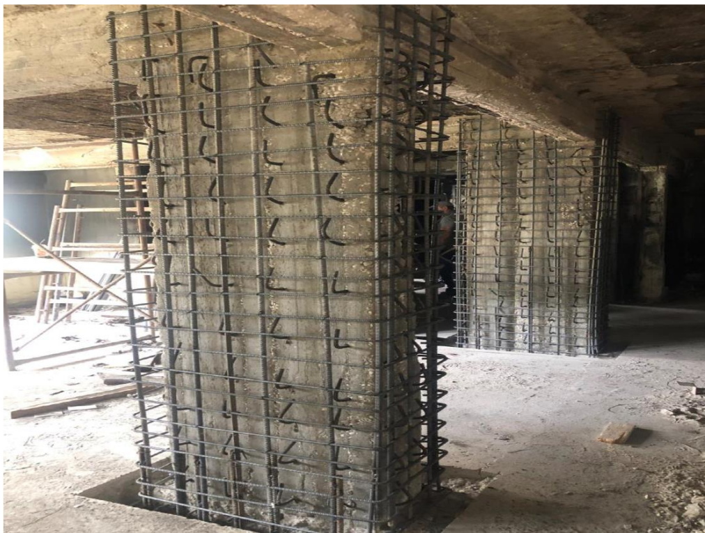
Ενίσχυση των υποστηλωμάτων με μανδύες
