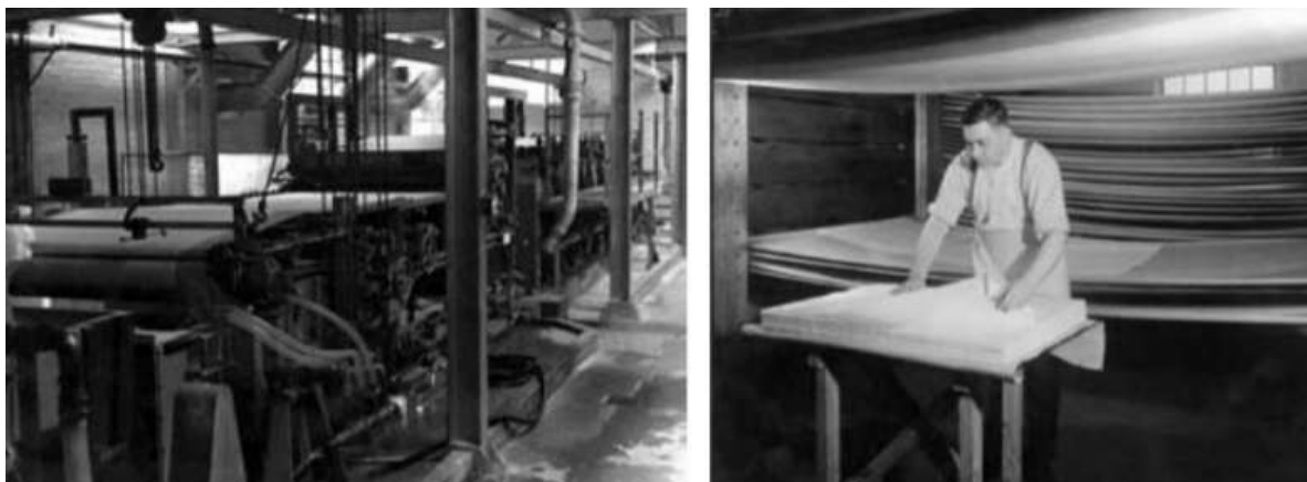
Εικόνα 18 Αχρονολόγητες, περίπου δεκαετίας του 1950, (αριστερά) φωτογραφία της μηχανής κολλαρίσματος ζελατίνης στο ισόγειο ενός από τα κτήρια, (δεξιά) η σοφίτα στεγνώματος στον πρώτο όροφο του ίδιου κτηρίου. (Nick Pearson). Πηγή: https://www.yumpu.com/en/document/read/47952908/laverstoke-mill-whitchurch-hampshire-english-heritage
