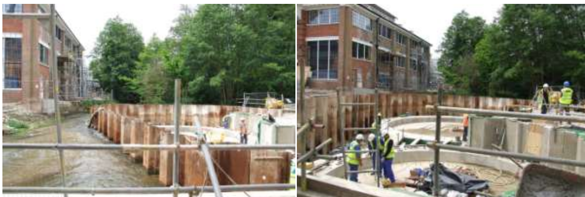
Εικόνα 25 Κατασκευές και διαχείριση εργοταξίου. Πηγή: https://www.constructionnews.co.uk/
