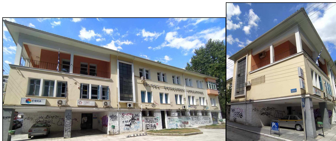
Σχήμα 3.24. Φωτογραφική αποτύπωση Νότιας και Δυτικής όψης κτίσματος (Πηγή : ίδια)
