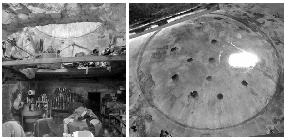
Εικ. 56, 57. Η αριστερή φωτογραφία αποτυπώνει το θερμό χώρο στο γυναικείο τμήμα του χαμάμ. Στο επάνω τμήμα της φωτογραφίας διακρίνεται η βάση του θόλου. Στη δεξιά φωτογραφία αποτυπώνεται ο θόλος του θερμού αυτού χώρου, όπου διακρίνεται η αστεροειδής διάταξη των φωτιστικών οπών, διάταξη που αποτυπώνεται και στην κάτοψη του M. Kiel (φωτ.τ.σ., 2017).
