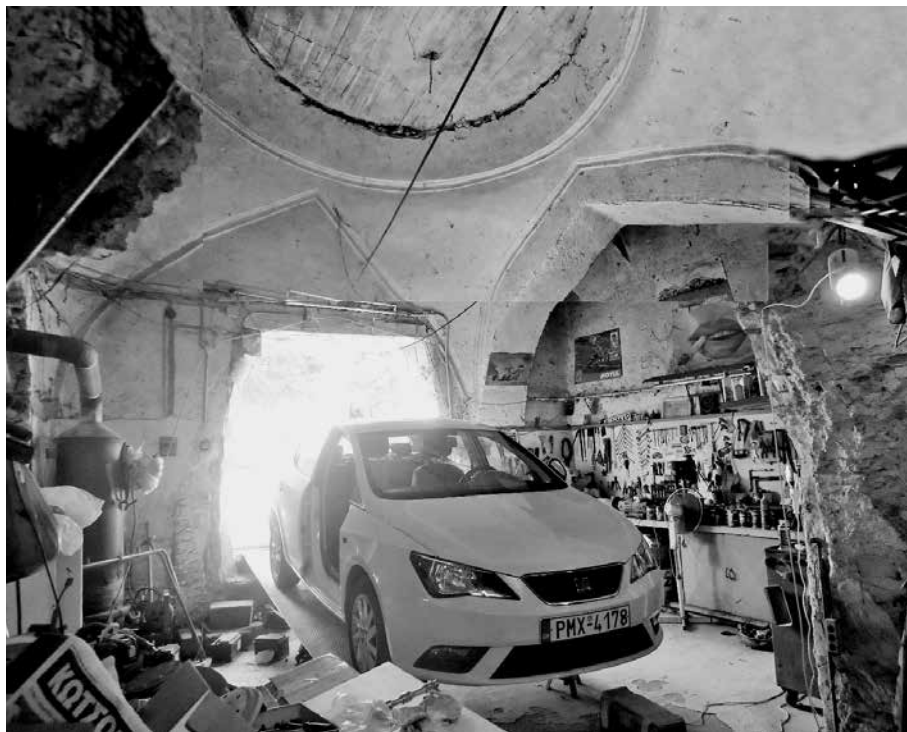
Εικ. 51. Φωτογραφία από τον διπλό χώρο του χλιαρού τμήματος ( soşukluk ), κεντρικό και μικρότερο παράπλευρο, στο ανδρικό (δυτικό) τμήμα του χαμάμι. Διακρίνεται ο κατεστραμμένος θόλος του κεντρικού τμήματος και τα οξυκόρυφα τόξα, όπου το δεξί οξυκόρυφο τοξωτό άνοιγμα ένωσε το κεντρικό χλιαρό τμήμα με τον μακρόστενο παράπλευρο χώρο (διακρίνεται ο τοίχος του στο βάθος όπου είναι ανηρτημένα τα εργαλεία του συνεργείου) που στεγαζόταν από τρεις μικρούς θόλους σε παράταξη. Το αριστερό άνοιγμα δεν υπήρχε και διανοίχθηκε εκ των υστέρων για τη λειτουργία (είσοδο) του συνεργείου. Αντιστοιχούσε σε τοίχο ανάμεσα στο χώρο του κεντρικού χλιαρού τμήματος και στο χώρο της Εισόδου/Αποδυτηρίων ( camekân ), που είναι πια κατεστραμμένοι. - (φωτ.τ.σ., 2017).
