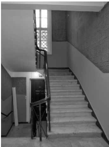
Εικ. 10: Κεντρικό κλιμακοστάσιο. Πηγή: Αρχείο Στ. Παπότη
