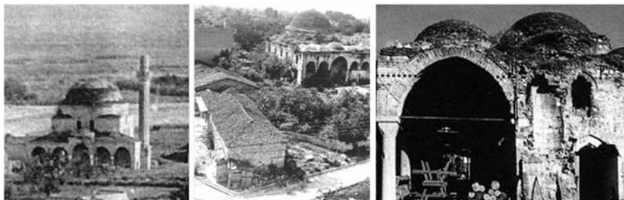
Εικ. 2: α. Μεχμέτ Μπέη τζαμί, http://old.serres.gr/oth_ktiria/el/mehmedBey , β. Τζινζιρολί τζαμί, φυλλάδιο ΥΠΠΟΑ, γ. Μουσταφά Μπέη τζαμί, http://www.serrelib.gr/serres6.htm .
