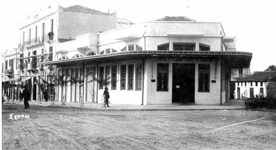
Εικ. 9: Η προσωρινή εγκατάσταση της Τράπεζας Αθηνών στο κτίριο Περδικάρη στην πλατεία Σιταγοράς (Δήμητρας) γύρω στα 1930. Διακρίνονται στα αριστερά οι σκαλωσιές κατασκευής 3ου ορόφου στο ξενοδοχείο «Κωνσταντινούπολις» (φωτο Δαϊρετζόγλου, Γ.Α.Κ Σερρών).
