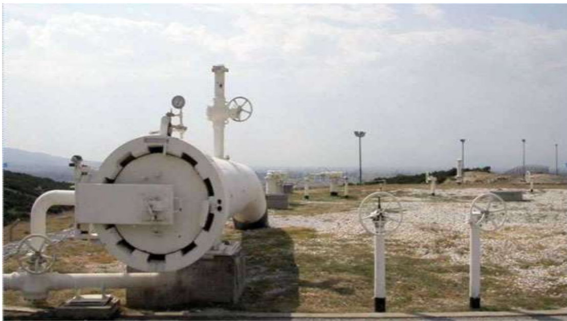
Εικόνα 26. Ξεστροπαγίδα αποστολής rig
