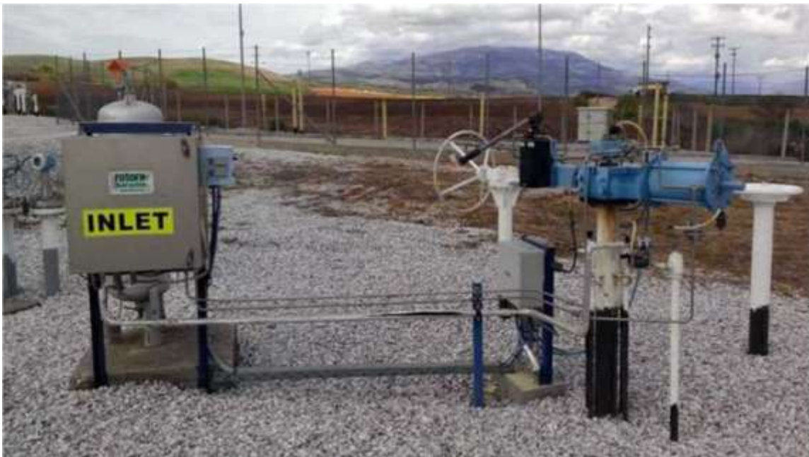
Εικόνα 32. Βάνα εισόδου με τοπικό και απομακρυσμένο χειρισμό
