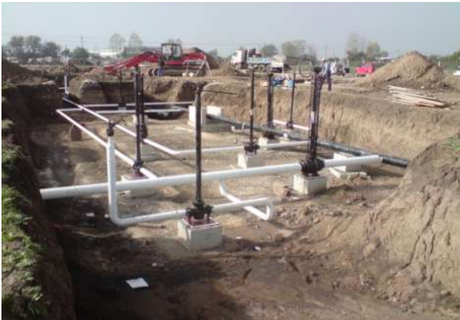
Εικόνα 20.Κατασκευή Βανοστασίου
