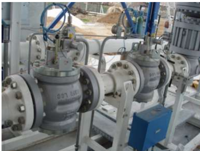
Εικόνα 41. Βάνα ακαριαίας διακοπής
