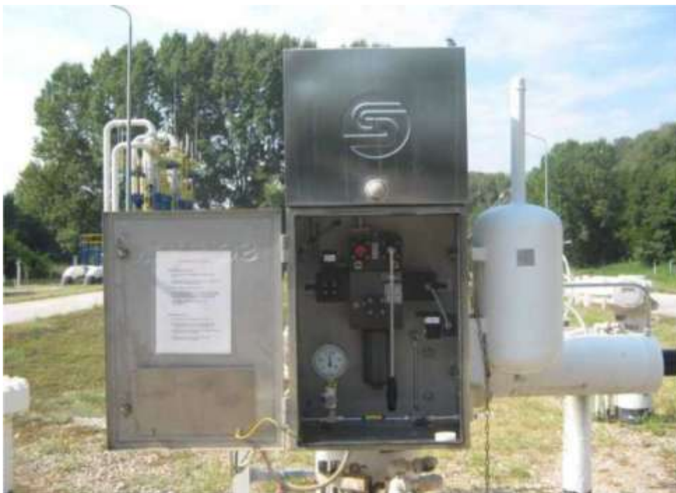
Εικόνα 22. Χειριστήριο βάνας για τοπικό ή απομακρυσμένο χειρισμό
