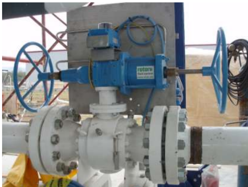
Εικόνα 36.Αυτόματη βάνα μετρητικής γραμμής
