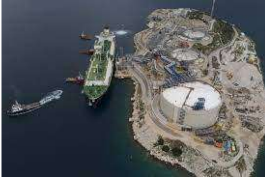
Εικόνα 166.Ο Τερματικός Σταθμός Υγροποιημένου Φυσικού Αερίου (ΥΦΑ) της Ρεθύμους
