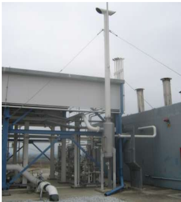
Εικόνα 39. Δοχείο εκτόνωσης
