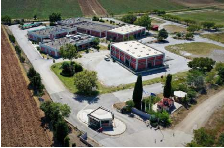
Εικόνα10.Εγκαταστάσεις Κέντρου Λειτουργίας & Συντήρησης
