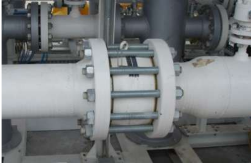
Εικόνα 48. Βάνα ανεπιστροφής
