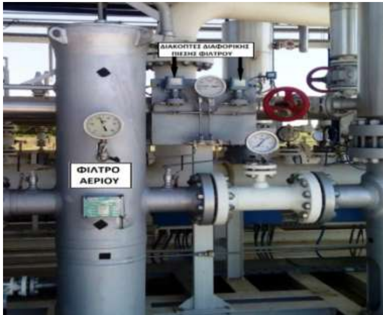
Εικόνα 37. Φίλτρο Φ.Α.
