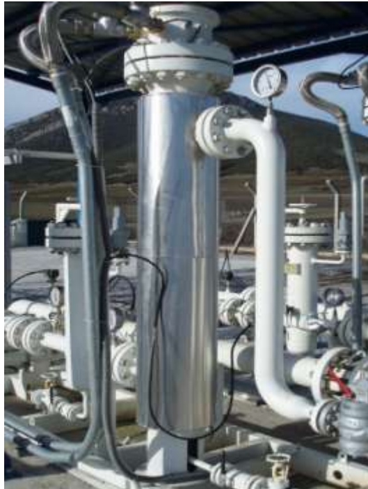
Εικόνα 40. Ηλεκτρικοί προθεμαντήρες
