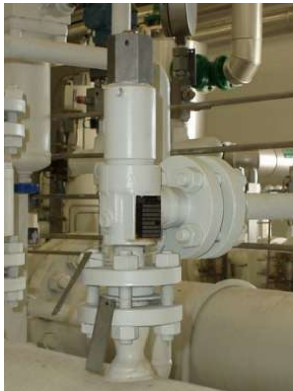
Εικόνα42.Ανακουφιστική βαλβίδα εκτόνωσης
