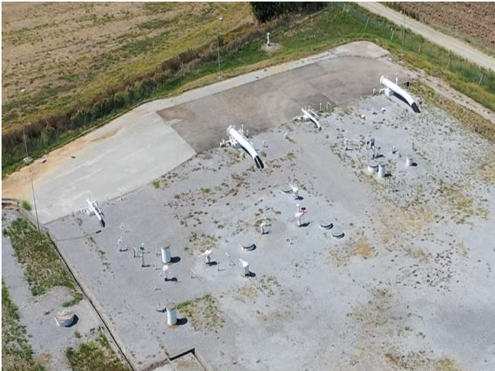
Εικόνα28. Εγκατάσταση με πολλές ξεστροπαγίδες [7e]
