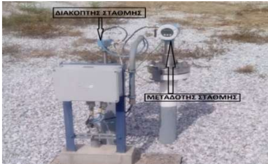
Εικόνα 33. Όργανα μέτρησης στάθμης [7e]
