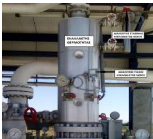
Εικόνα 38. Εναλλάκτης Θερμότητας
