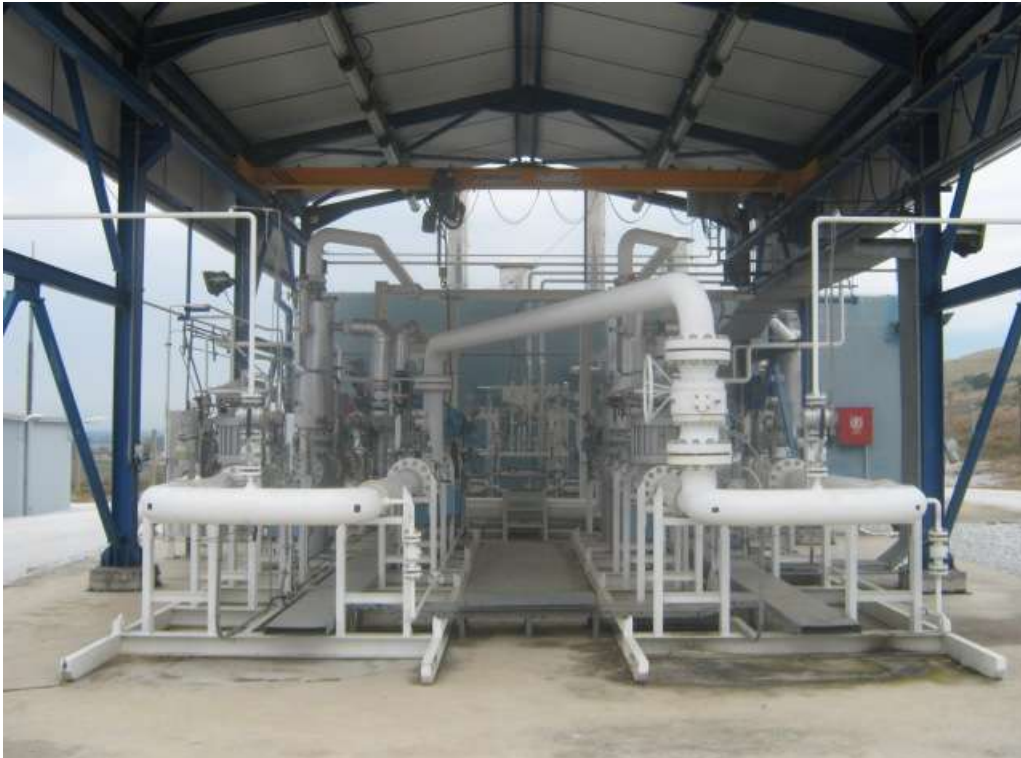
Εικόνα 47. Παρακαμπτήρια γραμμή – διασύνδεσης [7e]
