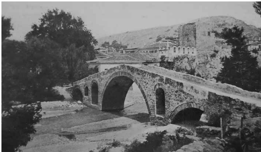
Εικ. 4. Το τρίτοξο πέτρινο γεφύρι, κατασκευασμένη κατά την ηπειρώτικη τυπολογία, πάνω από τον ποταμό Κρουσοβίτη (γέφυρα του Κρουσοβίτη ή γέφυρα του Σταυρού) που ένωνε τα δύο τμήματα της πόλης, σε φωτογραφία των αρχών του 20 ου αι. Πίσω από τη γέφυρα διακρίνεται ο βυζαντινός πύργος του Ανδρόνικου Γ' περιστοιχιζόμενος από τις οικίες στο λοφώδες Βαρόσι (Πηγή: Βασίλης Τζανακάρης, Το ΣΙΔΗΡΟΚΑΣΤΡΟ επί πτερυγών ιστορίας, έκδοση Δήμου Σιδηροκάστρου, Θεσσαλονίκη, 2002, σ. 37).
