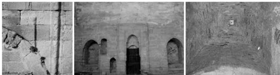
Εικ. 8: α. εξωτερικοί λαξευτοί λίθοι, β. άποψη της εσωτερικής κύριας όψης, γ. σκαφοειδής θόλος πλευρικού διαμερίσματος.
