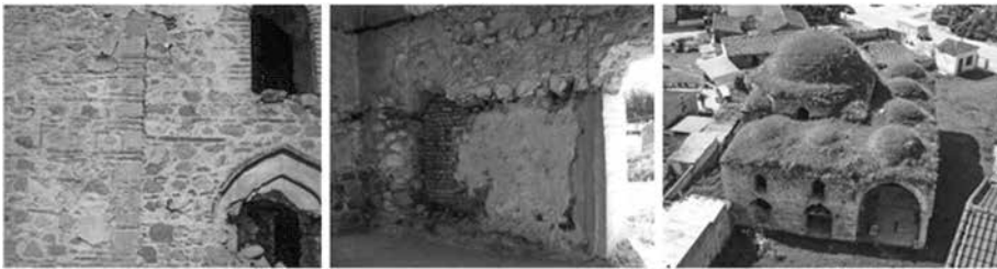
Εικ. 7: α. Εξωτερικός αρμός σύνδεσης των τοιχοποιιών, β. επεμβάσεις στο εσωτερικό του μνημείου, γ. άποψη της κατάστασης διατήρησης της επίστεψης του τεμένους.
