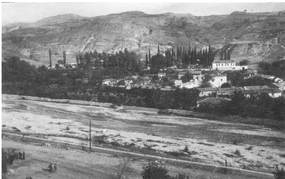
Εικ. 10. Σέρρες, Συλλογή Β. Ι. Τζανακάρη. Μερική άποψη της συνοικίας Κατακονόξι με το οικοδομικό συγκρότημα της Λιόκαλης στο μέσο γειτονιάς. Δεύτερη δεκαετία 20ού αιώνα.
