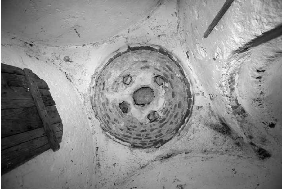
Εικ. 13. Χαμάμι Νέας Ζίχνης. Χώρος Ε - Θόλος αποχωρητηρίου (εσωτερικά) (φωτογράφιση: Ε. Κρίνου).
