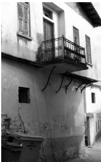
Εικ. 18: Λεπτομέρεια μεταλλικών αντηρίδων σε σπίτι του οικισμού Εμι. Παπά, αρχές 20 ού αι. (Α.Μ.402).
