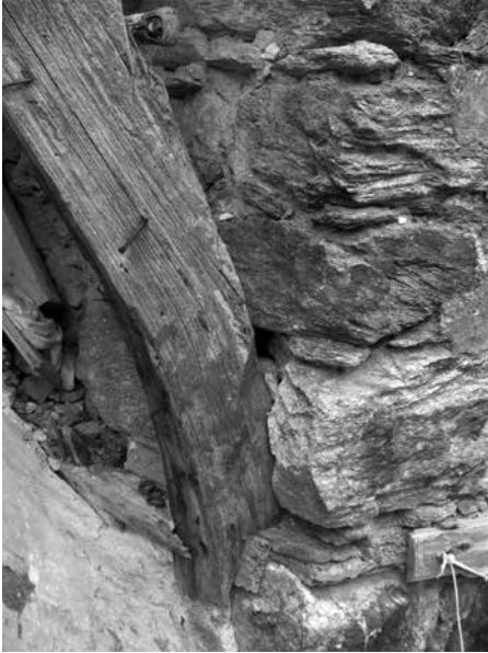
Εικ. 11: Λεπτομέρεια σύνδεσης με εντρομία της μπαγιάντας με το χατίλι. Άνω Πορόια, τέλος 18 ου αι. (Α.Μ.101).
