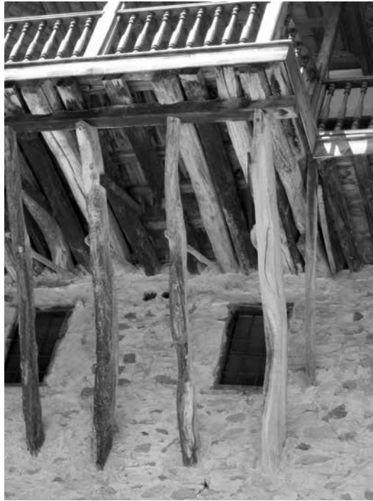
Εικ. 16: Ευθύγραμμες παγιάντες, καρφωμένες με σφυρηλάτους ήλους πάνω στο οριζόντιο καδρόνι, που συνδέει τα ξύλινα φουρούσια, σε κίосκι της μονής Τιμίου Προδρόμου.
