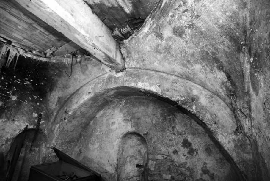
Εικ. 5. Χαμάμι Νέας Ζίχνης. Χλιαρός Χώρος Β - Τυφλό τόξο (δυτικός τοίχος) (φωτογράφιση: Ε. Κρίνου).
