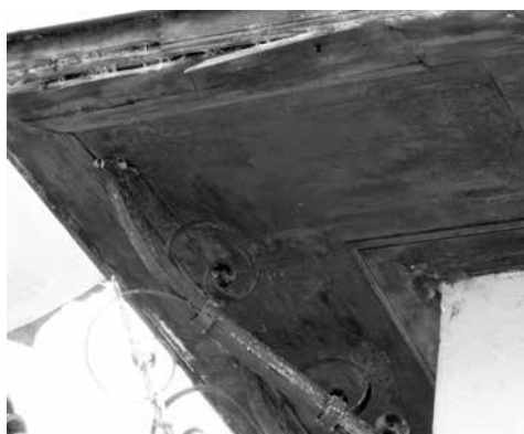
Εικ. 18: Λεπτομέρεια μεταλλικών αντηρίδων σε σπίτι του οικισμού Εμι. Παπά, αρχές 20 ού αι. (Α.Μ.402).
