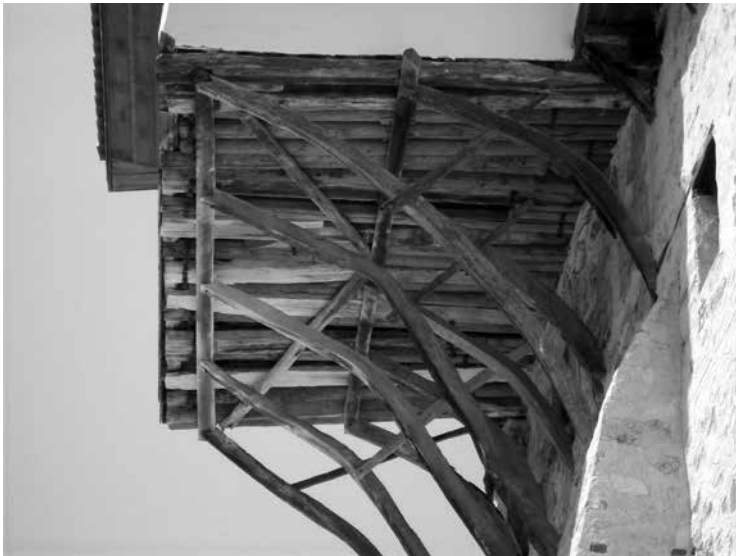
Εικ. 17: Διπλή σειρά καμπύλων αντηρίδων, που υποστηρίζουν το λιμηρή προεξοχή μοναδικού σαχισιού, στη νότια πλευρά της μονής Τιμίου Προδρόμου.
