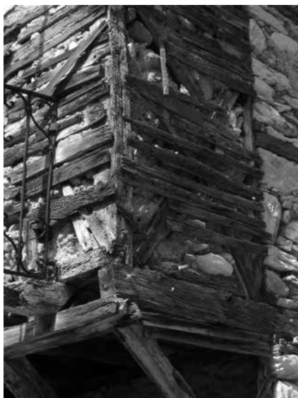
Εικ. 5: Λεπτομέρεια ξύλινου εξώστεγου, Άγ. Πνεύμα, τέλος του 18ου αι. (Α.Μ.703).
