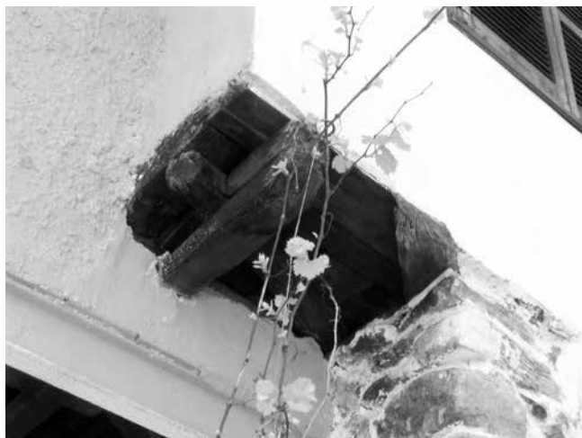
Εικ. 6: Λεπτομέρεια εκφορικού συστήματος ξύλινων δοκαριών σε εξώστεγο. Άνω Πορόια, αρχές 19 ου αι. (Α.Μ.135).
