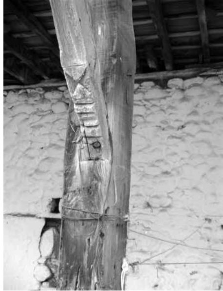
Εικ. 12: Λεπτομέρεια διακόσμησης ξύλινης μπαγιάντας καρφωμένης με πλατυκέφαλο γυφτόκαρφο στο ντιρέκι, σε ιστορική κατοικία του οικισμού Εμι. Παπά, τέλος 18 ου αι. (Α.Μ.433).
