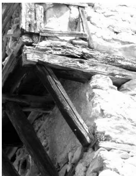
Εικ. 10: Λεπτομέρεια βάσης των ξύλων προεξοχής στο εξωτερικό του δίδυμου ξυλόδεσμου, στο χατίλι. Άγ. Πνεύμα, τέλος του 18 ου αι. (Α.Μ.709).
