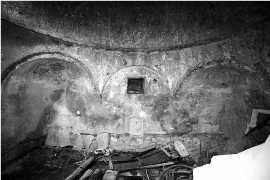
Εικ. 12. Χαμάμι Νέας Ζίχνης. Θερμός χώρος Γ - βόρειος τοίχος (εσωτερικά) (φωτογράφιση: Ε. Κρίνου).
