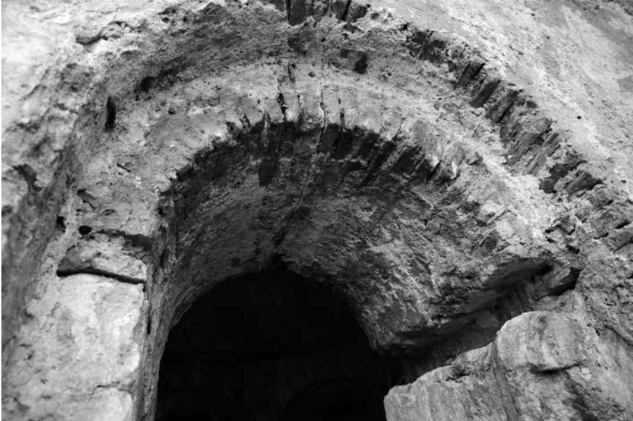
Εικ. 15. Θύρα πρόσβασης από τον χλιαρό Χώρο Β προς τον θερμό Χώρο Γ (πλινθόκτιστο τόξο) (φωτογράφιση: Ε. Κρίνου).
