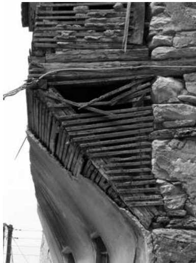
Εικ. 8: Επένδυση αντιστήριξης προεξοχής με κατασκευή από μπαγδατί. Αγ. Πνεύμα, αρχές 20 ού αι. (Α.Μ.765).
