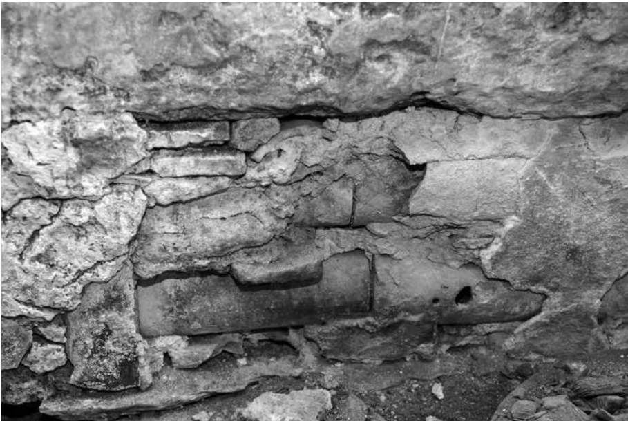
Εικ. 14. Χαμάμι Νέας Ζίχνης. Χλιαρός Χώρος Β - Πήλινοι αγωγοί διανομής νερού (φωτογράφιση: Ε. Κρίνου).
