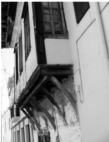
Εικ. 9: Ξύλα αντιστήριξης προεξοχής δίχως επένδυση, που δίνουν την εικόνα ξύλινων δοκαριών που προεξέχουν. Ροδολίβος, μέσα 19 ου αι. (Α.Μ.967).
