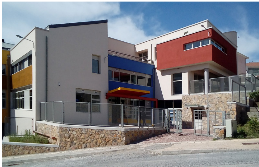
Εικόνα 2: Εξωτερικό του Πρότυπου Βιοκλιματικού Σχολικού Συγκροτήματος Δημοτικού- Νηπιαγωγείου στην Κοζάνη
