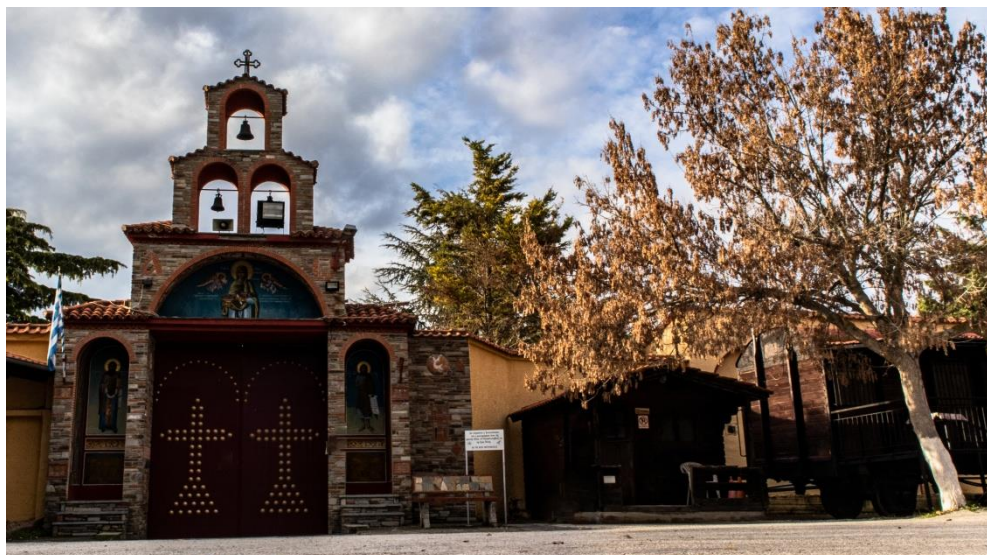
Εικόνα 16. Άποψη της Ιεράς Μονής Αγίας Παρασκευής Δομήρου.
