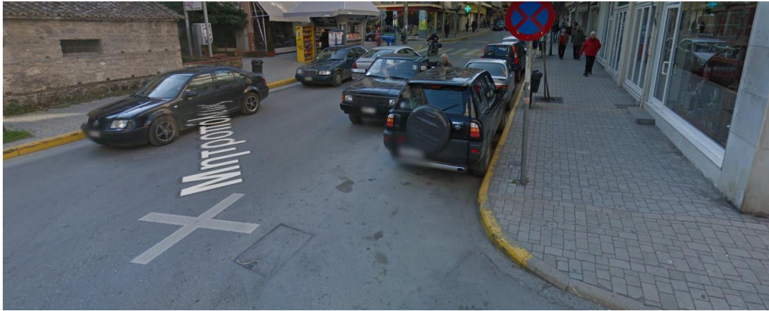
Εικόνα 21 Ικανό πλάτος πεζοδρομίου, ωστόσο διαφαίνεται η απουσία όδευσης τυφλών, καθώς και η κακοτεχνία στο επικλινές επίπεδο (ράμπα) (Google Street View)
