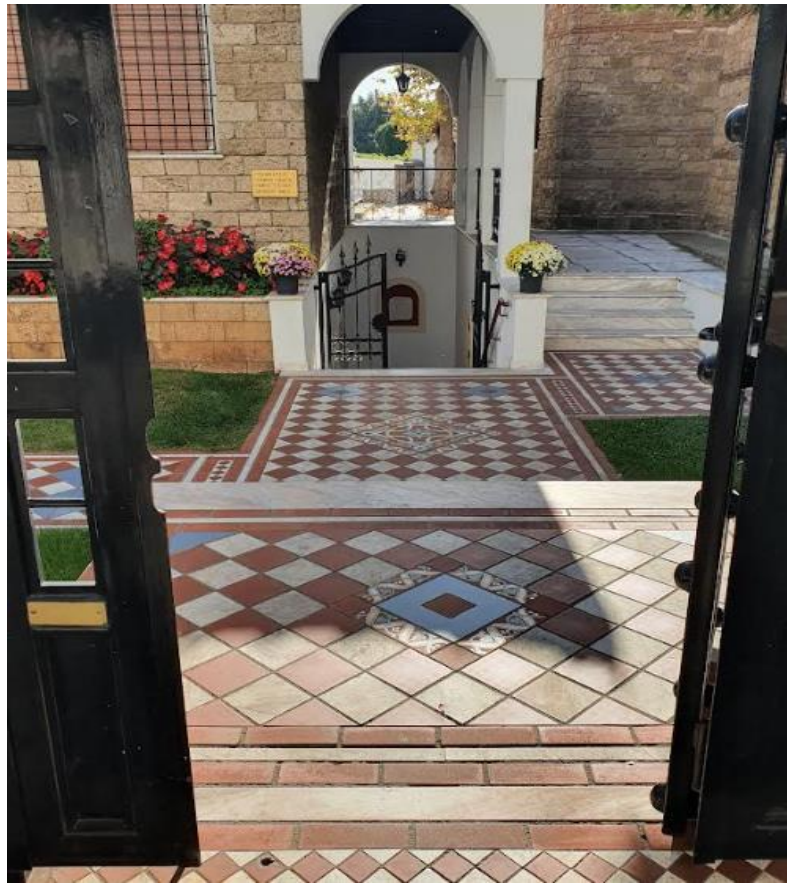
Εικόνα 23 Είσοδος στην Μητρόπολη της Βέροιας. Μηδενικά προσβάσιμη από εμποδιζόμενα άτομα λόγω εκλέπτυνσης και κλίμακας.
