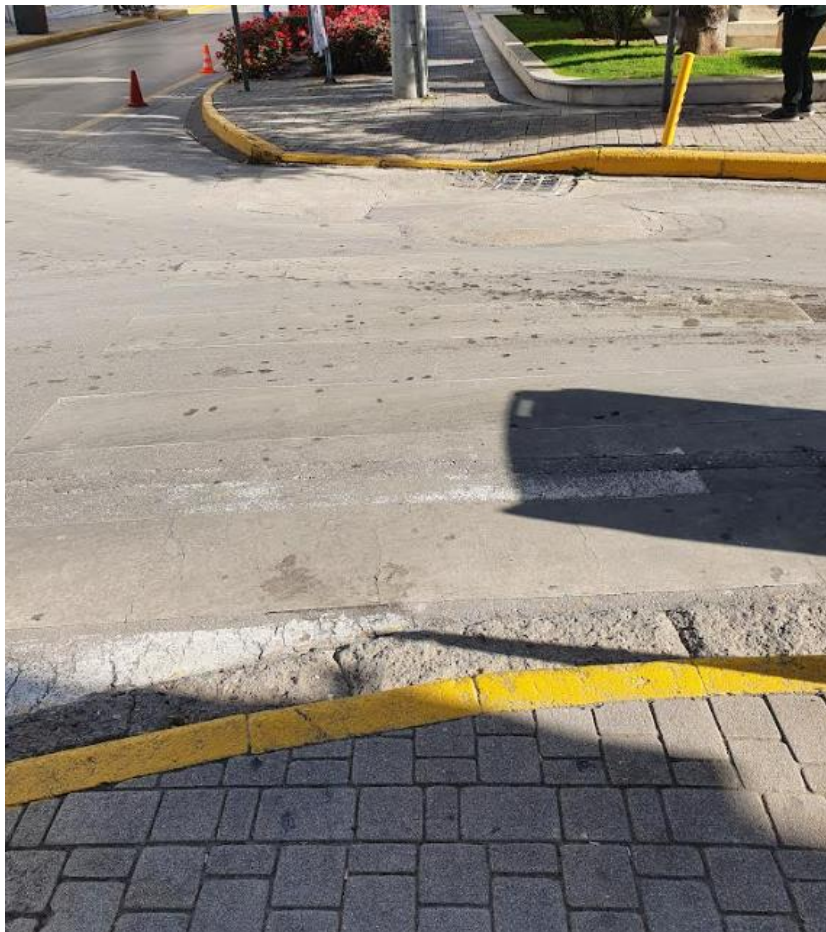
Εικόνα 20 Η ράμπα παρουσιάζει σημαντική υψομετρική διαφορά με το κράσπεδο, ενώ παρατηρείται κατόπιν αυτής σταθερό εμπόδιο και εκλέπτυνση της όδευσης λόγω θάμνων
