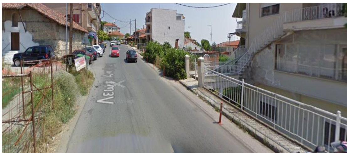
Εικόνα 38 Πλήρης απουσία πεζοδρομίου επί το σύνολο σχεδόν της Λεωφόρου Ανοιξης
