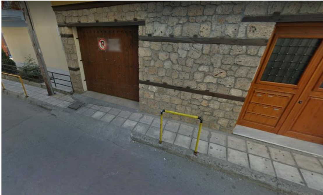
Εικόνα 42 Στενότητα πεζοδρομίου και απουσία χειρολισθήρων
