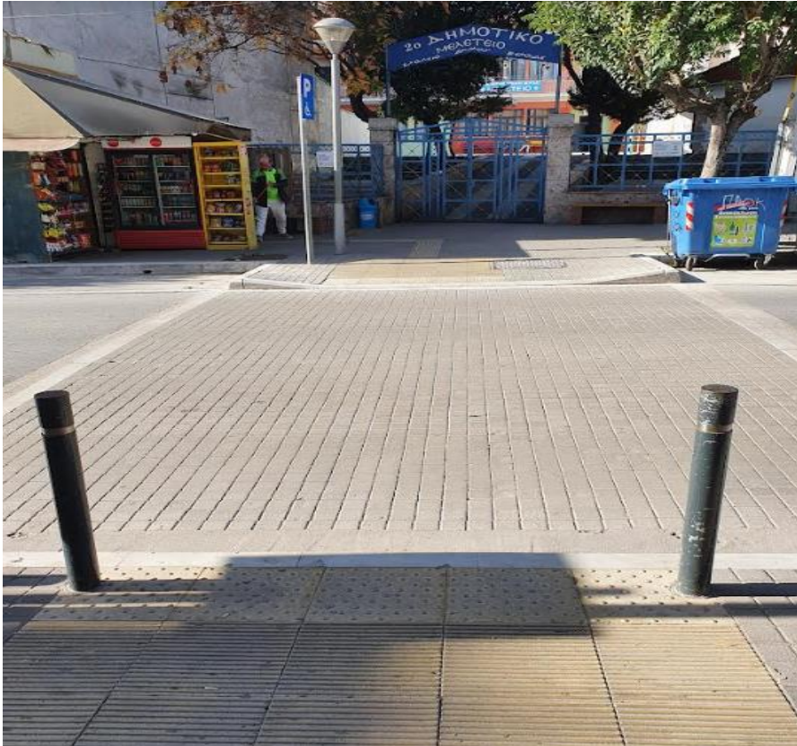
Εικόνα 31 Καλή πρακτική τοποθέτησης πλάκας "ΚΙΝΔΥΝΟΥ" σε όδευση τυφλών.
