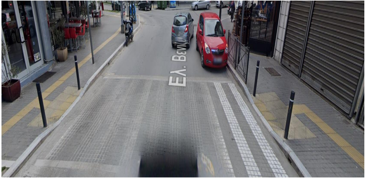
Εικόνα 27 Παρατηρείται ύπαρξη όδευσης τυφλών καθώς και επαρκή κεκλιμένα επίπεδα επί της έναρξης της Δ2
