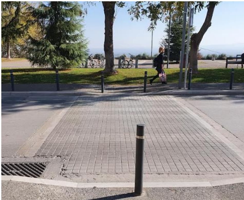
Εικόνα 36 Διάβαση με σταθερό εμπόδιο αστικού εξοπλισμού χωρίς χρήση πλακών όδευσης τυφλών.
