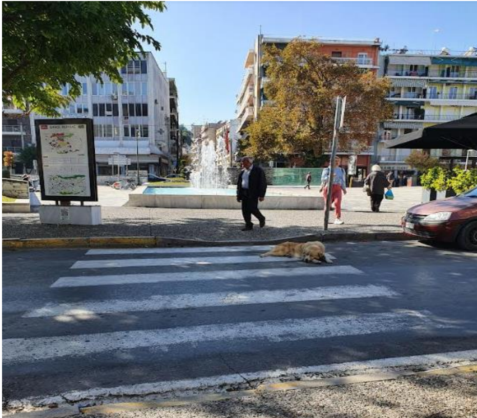
Εικόνα 40 Μονομερές κεκλιμένο επίπεδο και κακή κατάσταση οδοστρώματος στην Συμβολή της Πλατείας Ωρολογίου
