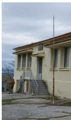
Εικόνα 4.402 Δάπεδο κλίμακας (Πηγή: Τ.Υ.)
