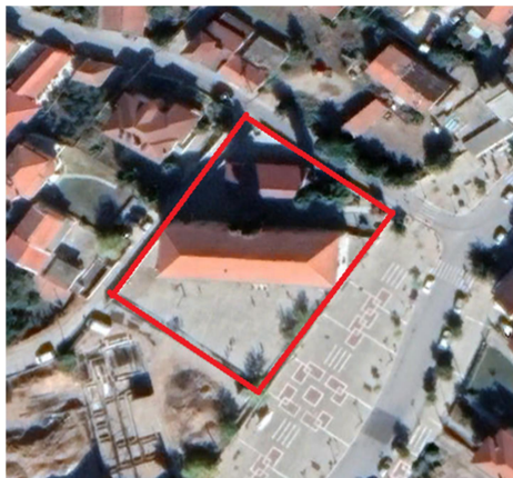
4.62 Νότιος προσανατολισμός Δημοτικού σχολείου Νέου Σουλίου (Ηλ. Πηγή: 14)
