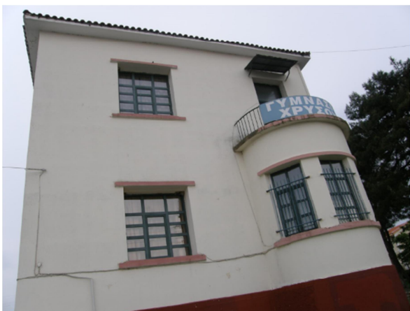
Εικόνα 4.234 Α όψη προ επεμβάσεων (Πηγή:Τ.Υ.)
