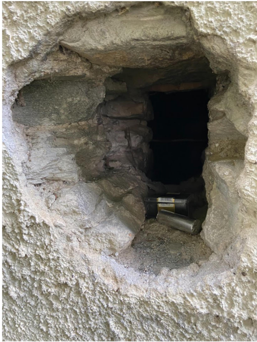
Εικόνα 4.181 Πάχος τοιχοποιίας (Πηγή: Τ.Υ.)
