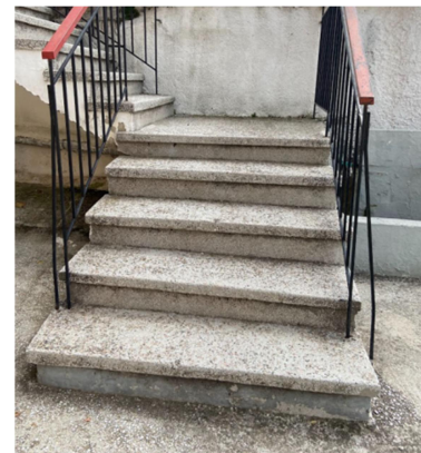
Εικόνα 4.47 Δάπεδο εξωτερικής κλίμακας επέκτασης (Πηγή: Τ.Υ.)
