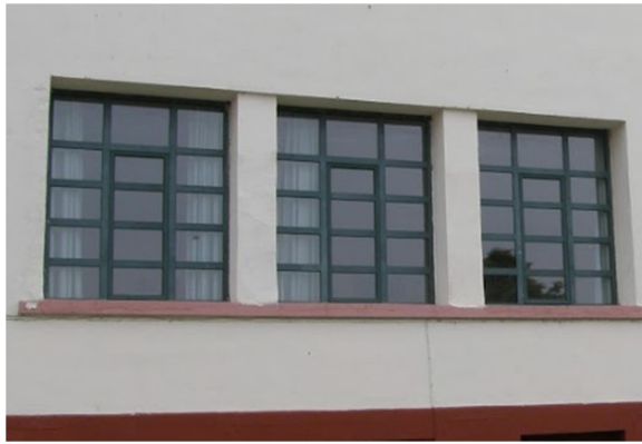
Εικόνα 4.218 Κουφώματα παραθύρων (Πηγή: Τ.Υ.)
