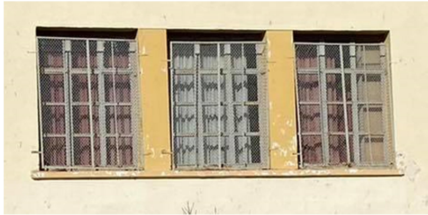
Εικόνα 4.158 Κουφώματα παραθύρων (Πηγή: Τ.Υ.)
