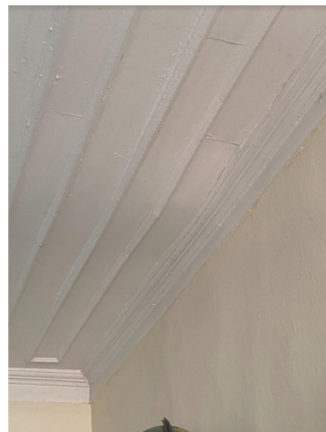
Εικόνα 4.35 Ψευδοροφή ορόφου (Πηγή: Τ.Υ.)
