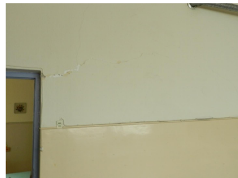
Εικόνα 4.401 Επίχρισμα εξωτερικής τοιχοποιίας (Πηγή: Τ.Υ.)
