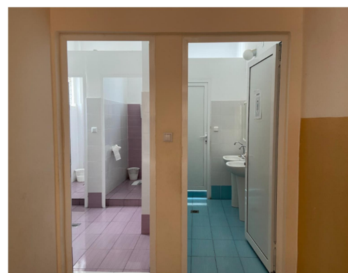
Εικόνα 4.74 Δάπεδο W.C. (Πηγή: Τ.Υ.)
