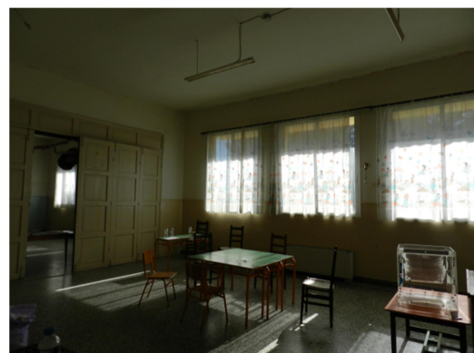
Εικόνα 4.391 Ξύλινα διαχωριστικά πετάσματα αιθουσών (Πηγή: Τ.Υ.)
