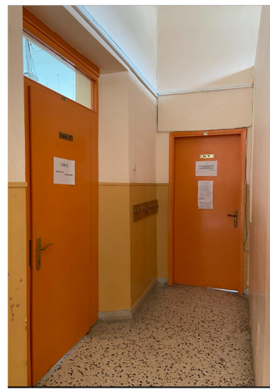
Εικόνα 4.80 Κουφώμα εσωτερικής πόρτας (Πηγή: Τ.Υ.)
