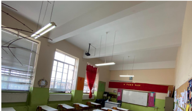
Εικόνα 4.71 Πλάκα ισογείου (Πηγή: Τ.Υ.)
