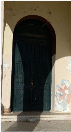
Εικόνα 4.157 Κουφώμα εξώπορτας (Πηγή: Τ.Υ.)
