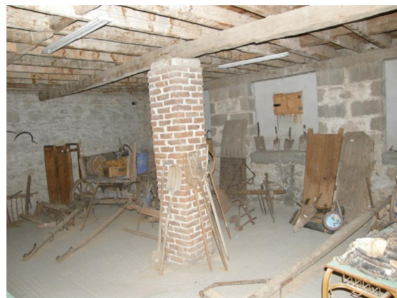
Εικόνα 4.212 Εμφανής λιθοδομή ημιπογείου (Πηγή: Τ.Υ.)
