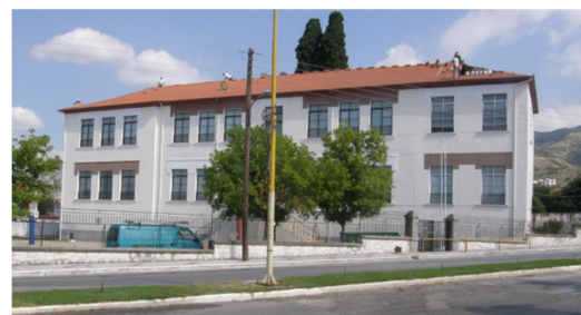
Εικόνα 4.58 Δημοτικό σχολείο 2022 (Πηγή: Τ.Υ.)
