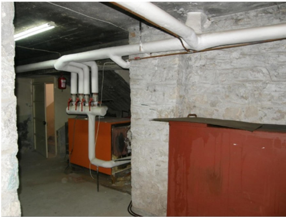
Εικόνα 4.211 Εμφανής λιθοδομή ημιπογείου (Πηγή: Τ.Υ.)
