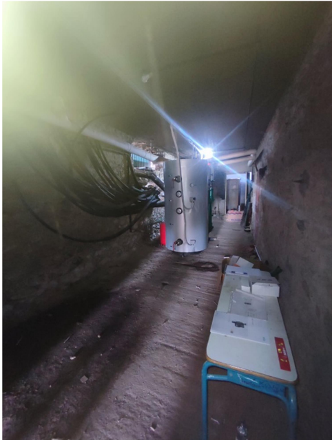
Εικόνα 4.277 Ανεπίχριστη εσωτερική τοιχοποιία υπογείου (Πηγή: Ζ.Κ.)
