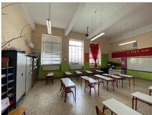
Εικόνα 4.73 Δάπεδο αίθουσας (Πηγή: Τ.Υ.)
