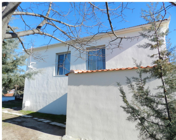
Εικόνα 4.110 Δ πλάγια όψη (Πηγή: Τ.Υ.)
