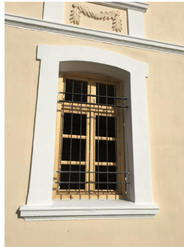
Εικόνα 4.96 Κουφώματα παραθύρων (Πηγή: Τ.Υ.)
