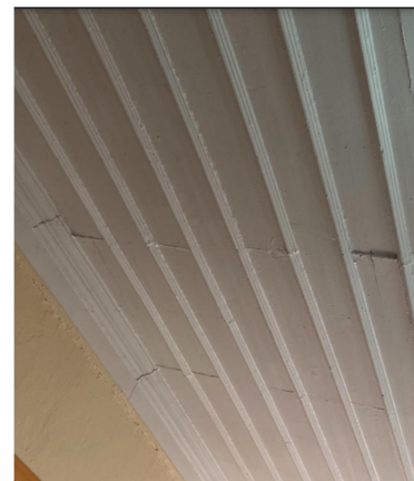
Εικόνα 4.36 Ψευδοροφή ορόφου (Πηγή: Τ.Υ.)
