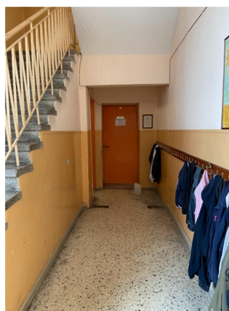
Εικόνα 4.76 Δάπεδο διαδρόμου (Πηγή: Τ.Υ.)
