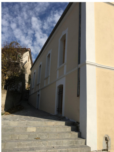
Εικόνα 4.90 Πλάγια Δ όψη (Πηγή: Τ.Υ.)
