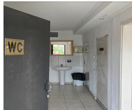
Εικόνα 4.23 W.C ισογείου (Πηγή: Τ.Υ.)
