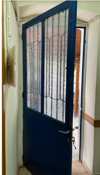
Εικόνα 4.186 Εξωτερική πόρτα ισογείου (Πηγή: Τ.Υ.)
