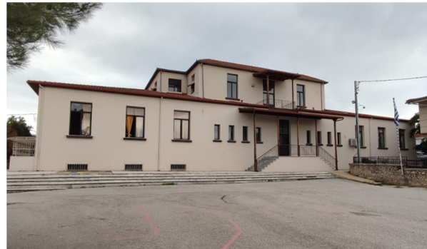
Εικόνα 4.329 Πίσω όψη (Πηγή: Ζ.Κ.)
