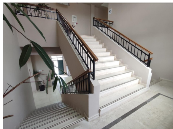
Εικόνα 4.255 Δάπεδο κλιμακοστασίου ανόδου στον όροφο (Πηγή: Ζ.Κ.)
