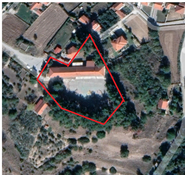
4.105 Νότιος προσανατολισμός Γυμνασίου Αγίου Πνεύματος (Ηλ. Πηγή: 14)
