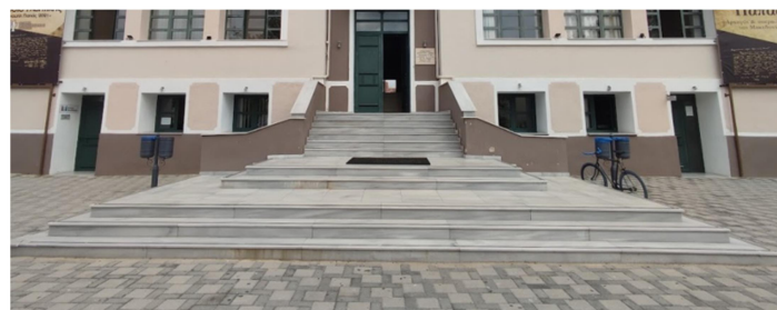
Εικόνα 4.251 Δάπεδο εξωτερικής κλίμακας εισόδου (Πηγή: Ζ.Κ.)
