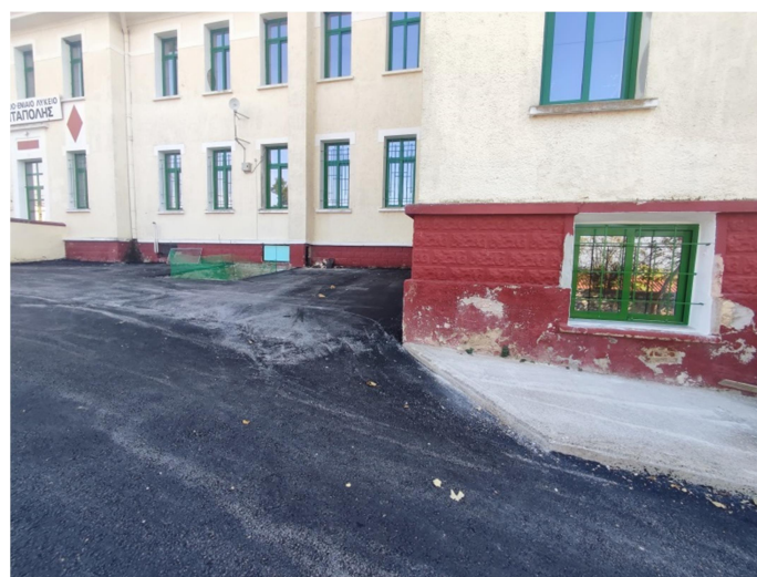
Εικόνα 4.276 Ανεπίχριστη εξωτερική τοιχοποιία υπογείου (Πηγή: Ζ.Κ.)
