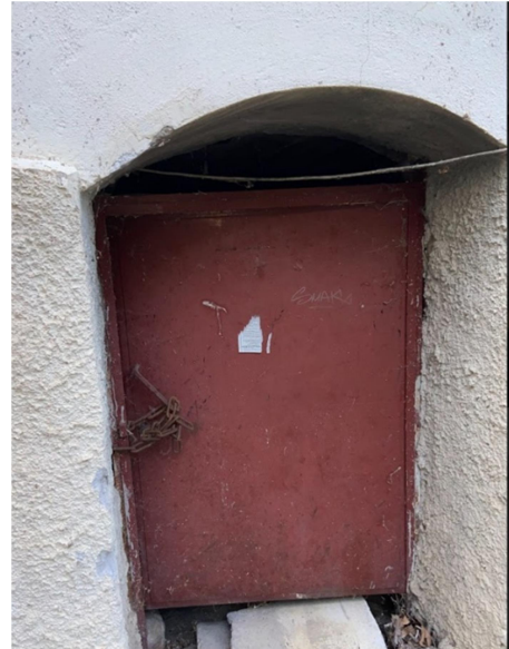
Εικόνα 4.187 Εξωτερική πόρτα υπογείου (Πηγή: Τ.Υ.)
