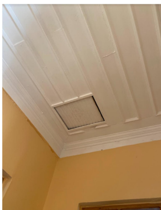
Εικόνα 4.34 Ψευδοροφή ορόφου (Πηγή: Τ.Υ)
