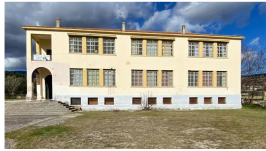
Εικόνα 4.151 Δημοτικό σχολείο 2021 (Πηγή: Τ.Υ.)
