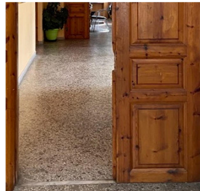
Εικόνα 4.42 Δάπεδο διαδρόμου ορόφου (Πηγή: Τ.Υ.)
