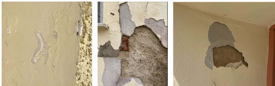
Εικόνα 4.54 Σημειακές εξωτερικές αποφλοιώσεις επιχρισμάτων (Πηγή: Τ.Υ.)
