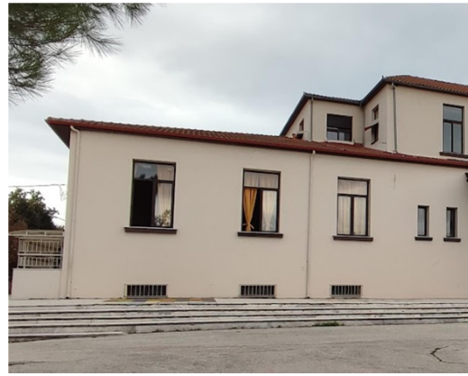
Εικόνα 4.336 Ανοίγματα υπογείου (Πηγή: Ζ.Κ.)
