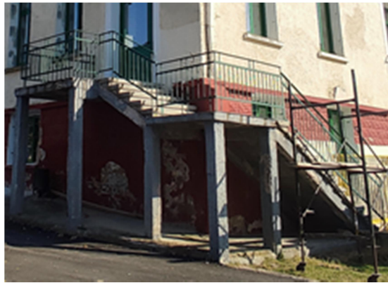
Εικόνα 4.282 Κλίμακα δευτερεύουσας εισόδου 2 (Πηγή: Ζ.Κ.)
