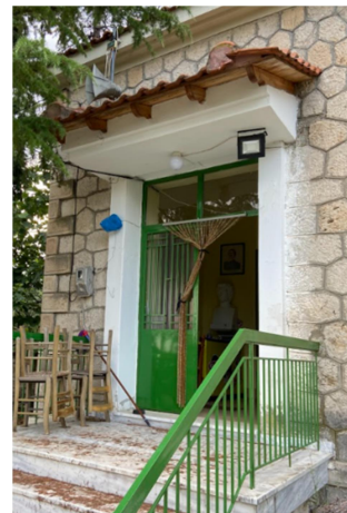
Εικόνα 4.168 Κουφώμα εξώπορτας (Πηγή: Τ.Υ.)
