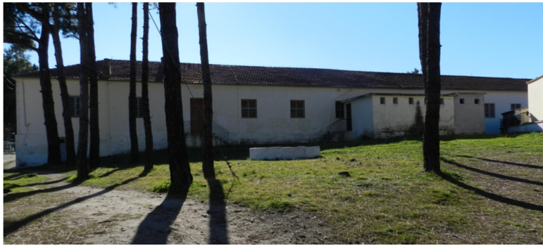
Εικόνα 4.108 Α τμήμα πίσω όψης (Πηγή: Τ.Υ.)
