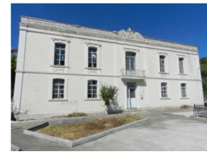
(Σ3) Παλιό Δημοτικό σχολείο Αγίου Πνεύματος
