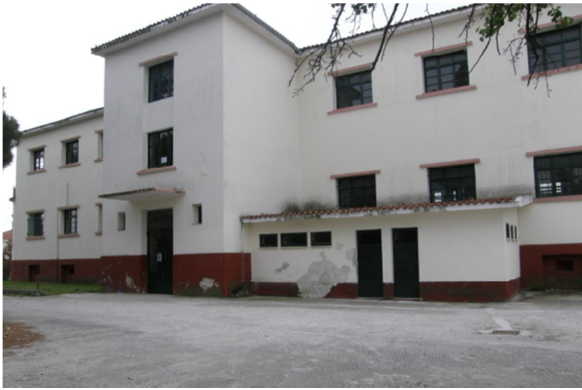
Εικόνα 4.232 Πίσω όψη προ επεμβάσεων (Πηγή:Τ.Υ.)
