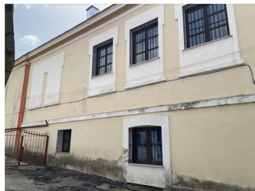
Εικόνα 4.9 Α τμήμα πίσω όψης (Πηγή: Τ.Υ.)
