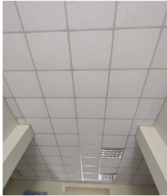
4.356 Ψευδοροφή με πλάκες ορυκτών ινών (Πηγή: Ζ.Κ.)
