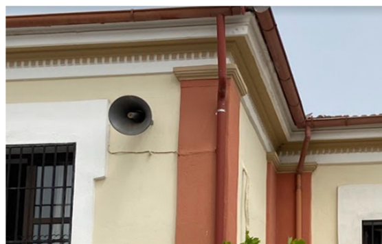
Εικόνα 4.17 Διακόσμηση τελειώματος στέγης (Πηγή: Τ.Υ.)
