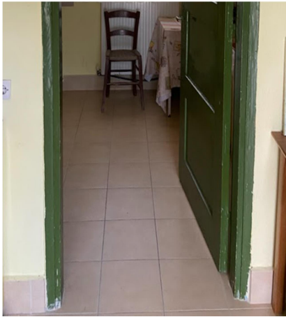
Εικόνα 4.169 Δάπεδο εσωτερικών χώρων (Πηγή: Τ.Υ.)
