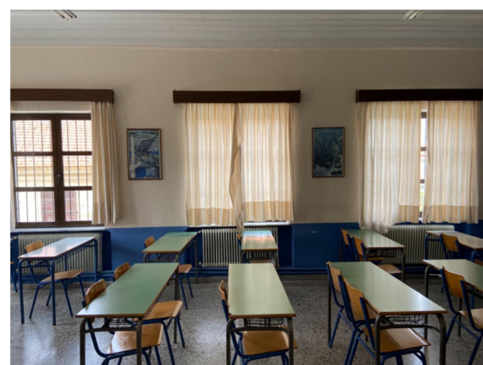
Εικόνα 4.28 Αίθουσα διδασκαλίας 2 ορόφου (Πηγή: Τ.Υ.)
