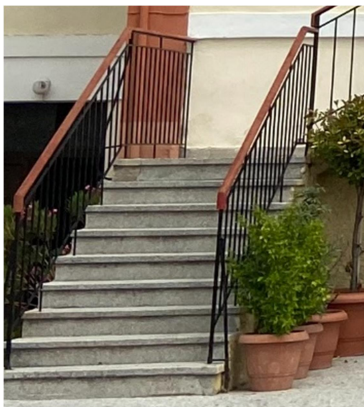
Εικόνα 4.45 Δάπεδο εξωτερικής κλίμακας (Πηγή: Τ.Υ.)
