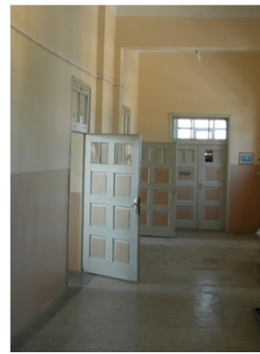
Εικόνα 4.219 Κουφώματα εσωτερικών θυρών (Πηγή: Τ.Υ.)
