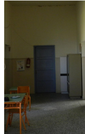
Εικόνα 4.406 Εσωτερική πόρτα (Πηγή: Τ.Υ.)
