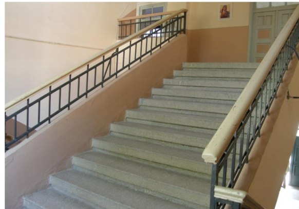
Εικόνα 4.221 Δάπεδο κλιμακοστασίου (Πηγή: Τ.Υ.)
