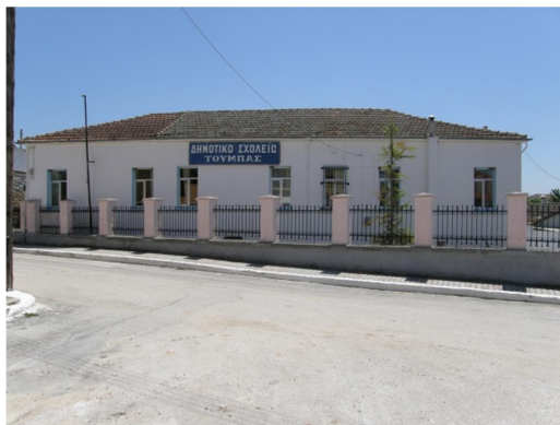
Εικόνα 4.315 Πίσω όψη προ επεμβάσεων (Πηγή: Τ.Υ.)
