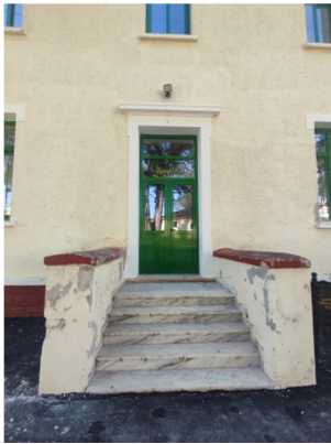
Εικόνα 4.281 Κλίμακα δευτερεύουσας εισόδου 1 (Πηγή: Ζ.Κ.)
