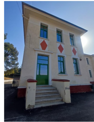
Εικόνα 4.283 Κλίμακα δευτερεύουσας εισόδου 3 (Πηγή: Ζ.Κ.)
