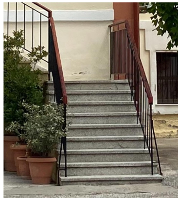
Εικόνα 4.46 Δάπεδο εξωτερικής κλίμακας (Πηγή: Τ.Υ.)
