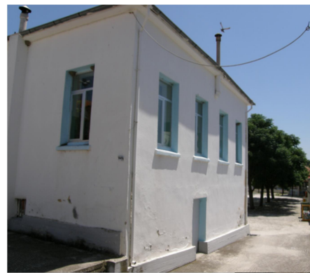
Εικόνα 4.316 Πλάγια ΝΔ όψη προ επεμβάσεων (Πηγή: Τ.Υ.)
