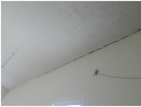
Εικόνα 4.398 Ψευδοροφή ισογείου (Πηγή: Τ.Υ.)
