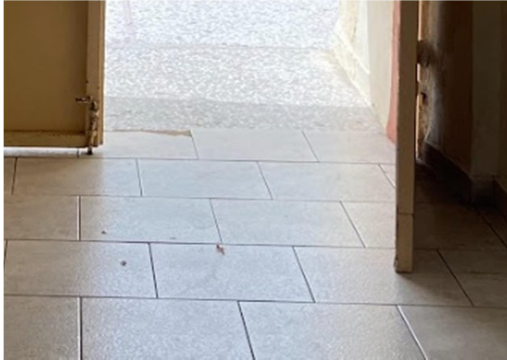
Εικόνα 4.37 Δάπεδο εισόδου ισογείου (Πηγή: Τ.Υ.)
