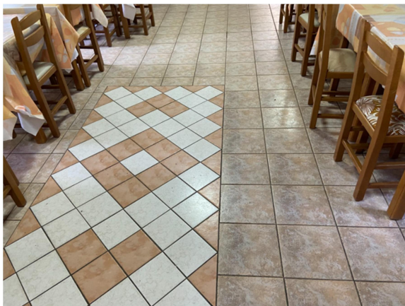
Εικόνα 4.183 Εσωτερικό δάπεδο (Πηγή: Τ.Υ.)
