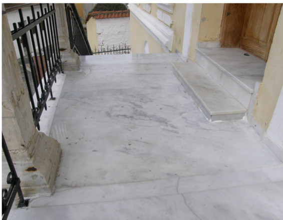
Εικόνα 4.144 Δάπεδο εξωτερικής κλίμακας (Πηγή: Τ.Υ.)
