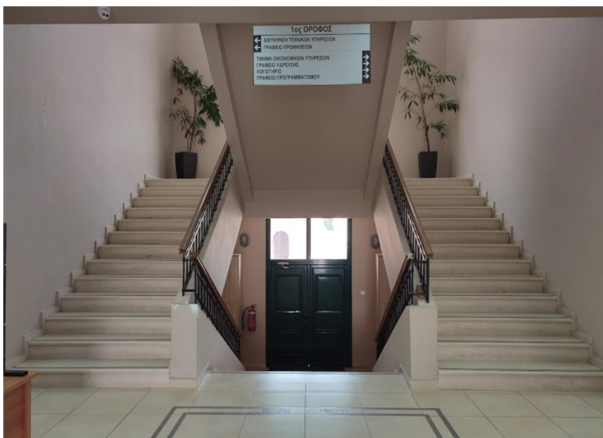
Εικόνα 4.254 Δάπεδο κλιμακοστασίου ανόδου στον όροφο (Πηγή: Ζ.Κ.)
