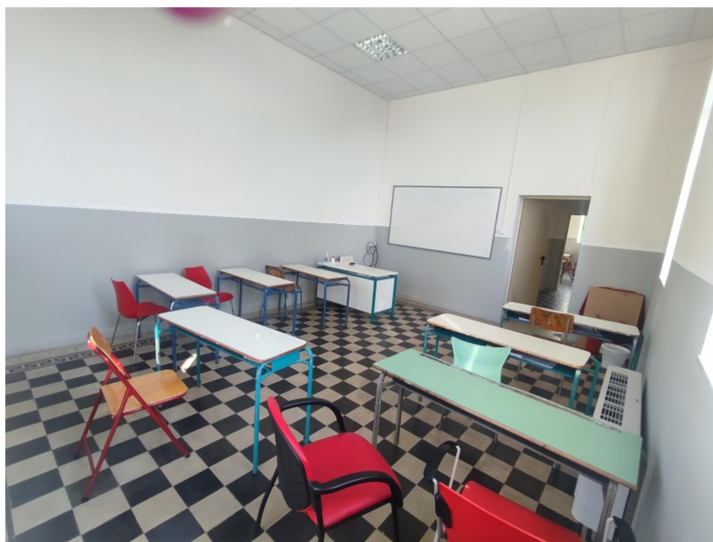
Εικόνα 4.287 Δάπεδο αίθουσας (Πηγή: Ζ.Κ.)
