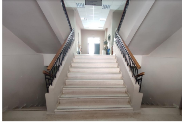
Εικόνα 4.253 Δάπεδο εσωτερικής κλίμακας εισόδου από πίσω όψη (Πηγή: Ζ.Κ.)
