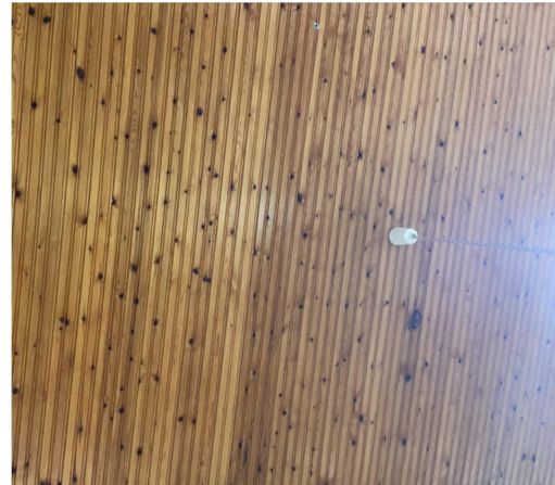
Εικόνα 4.189 Επένδυση οροφής (Πηγή: Τ.Υ.)
