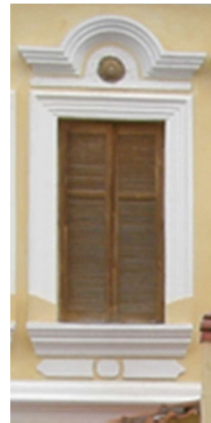
Εικόνα 4.139 Παράθυρο ορόφου (Πηγή: Τ.Υ.)
