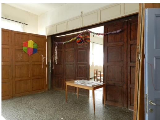
Εικόνα 4.390 Ξύλινα διαχωριστικά πετάσματα αιθουσών (Πηγή: Τ.Υ.)
