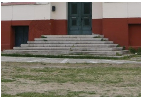
Εικόνα 4.222 Δάπεδο εξωτερικής κλίμακας (Πηγή: Τ.Υ.)
