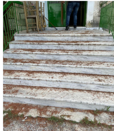
Εικόνα 4.170 Δάπεδο κλίμακας (Πηγή: Τ.Υ.)
