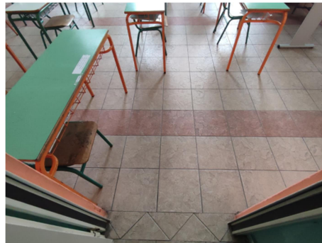
Εικόνα 4.348 Δάπεδο αίθουσας (Πηγή: Ζ.Κ.)
