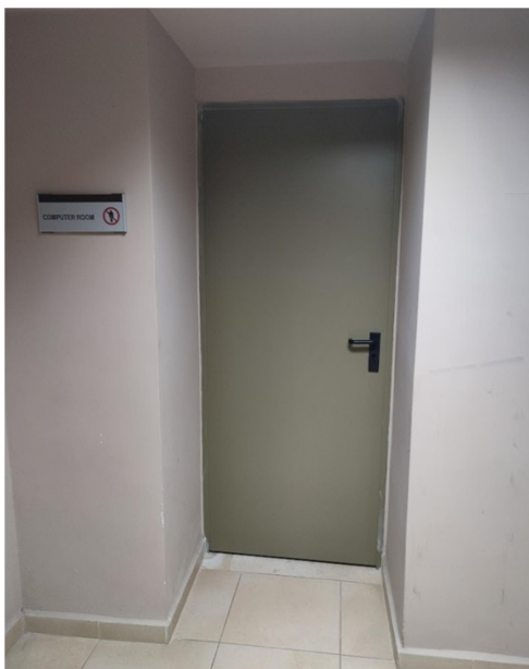
Εικόνα 4.259 Θύρα βιομηχανικής προέλευσης (Πηγή: Ζ.Κ.)
