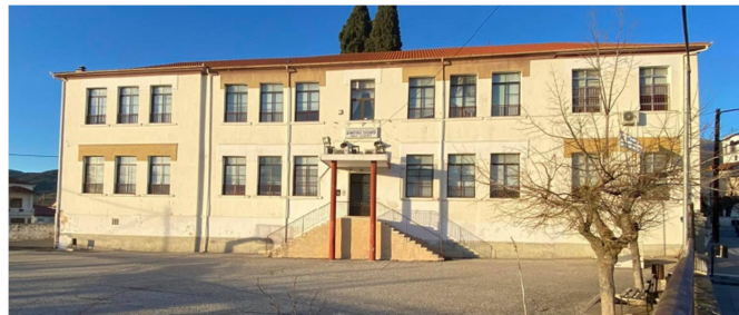
Εικόνα 4.57 Δημοτικό σχολείο 2020 (Πηγή: Τ.Υ.)
