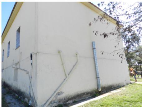
Εικόνα 4.400 Επίχρισμα εξωτερικής τοιχοποιίας (Πηγή: Τ.Υ.)
