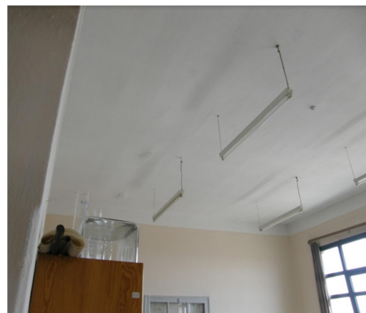
Εικόνα 4.214 Ψευδοροφή ορόφου(Πηγή: Τ.Υ.)
