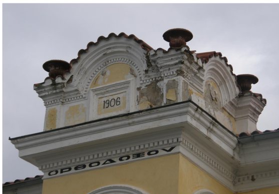
Εικόνα 4.130 Στέψη κτηρίου (Πηγή: Τ.Υ.)
