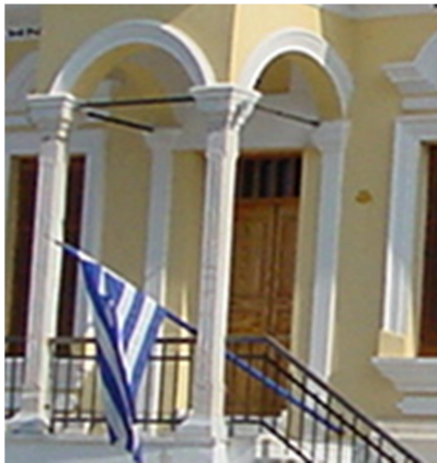
Εικόνα 4.137 Πόρτα κύριας εισόδου ορόφου (Πηγή: Τ.Υ.)
