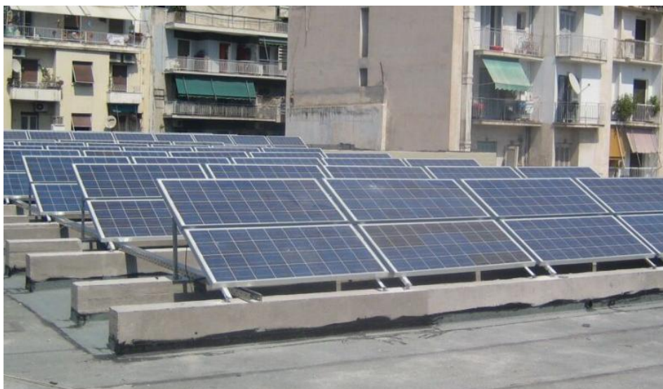
Εικόνα 1.15: Εγκατάσταση Φ/Β στο 4 ο Γυμνάσιο – Λύκειο Αθήνας (πηγή: www.photovoltaiic.gr )
