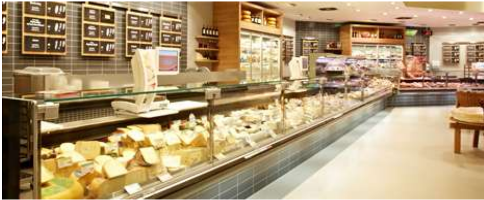
Εμπορική εγκατάσταση ψυκτικής μεταφοράς
