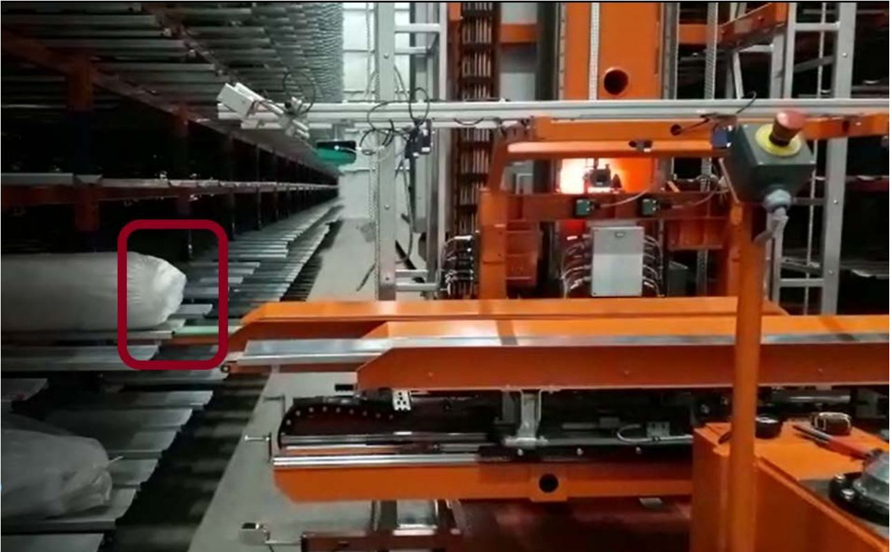
Εικόνα 6.8 – Δεύτερο στάδιο θέσης μηχανής, αρχική θέση X,Y,Z υψωμένη κατά 3 εκατοστά, Μηχανή έτοιμη για φόρτωση
