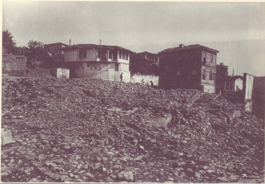
εικ. 6 : κατά τη διάρκεια κατασκευής της πλατείας
