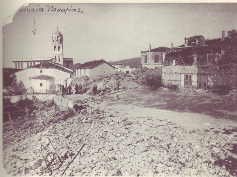
εικ. 5: κατά τη διάρκεια κατασκευής της πλατείας
