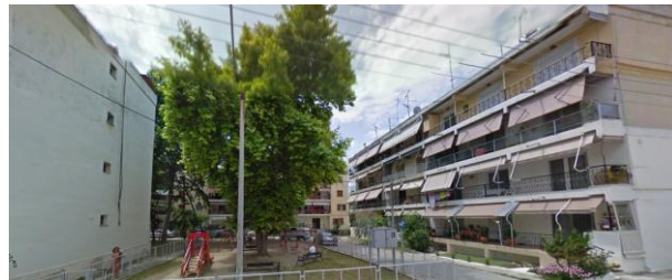
Εικ. 25: Ελεύθερος χώρος στο συγκρότημα 4
