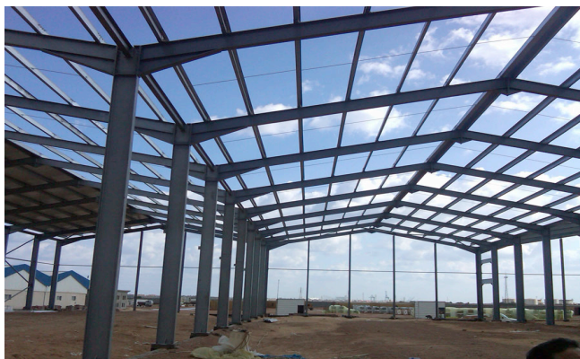
Εικόνα 3.4.1: Μεταλλική κατασκευή εγκατάστασης επιχείρησης
