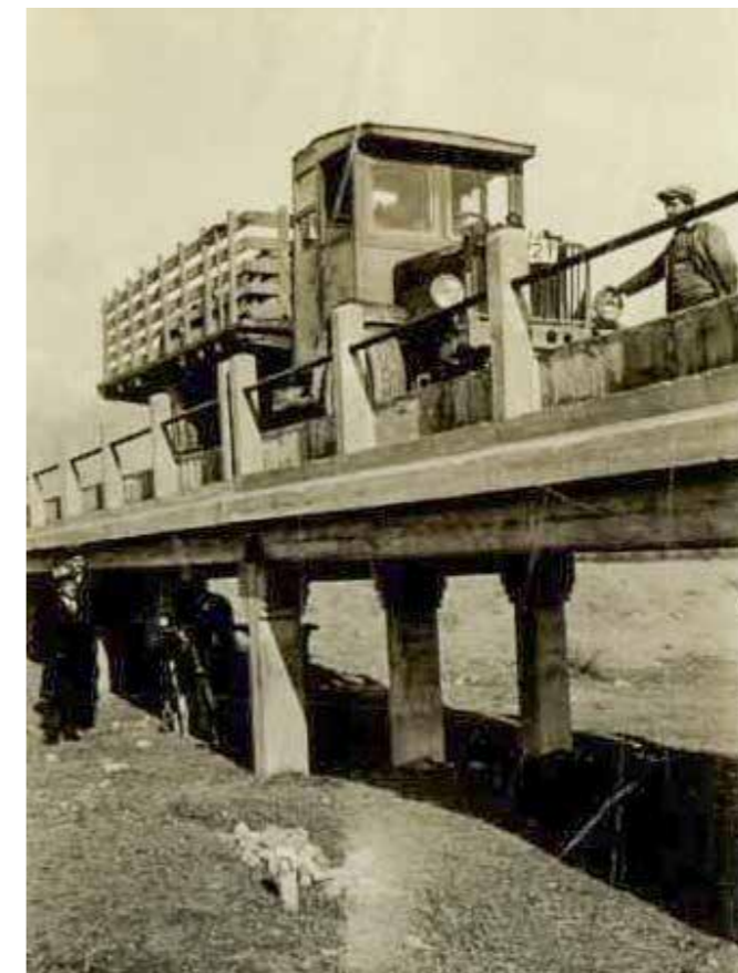
Εικ. 13. Έλεγχος αντοχής γέφυρας χειμάρρου Κερκινίτη. Διέλευση φορτίου 9 τόνων.
