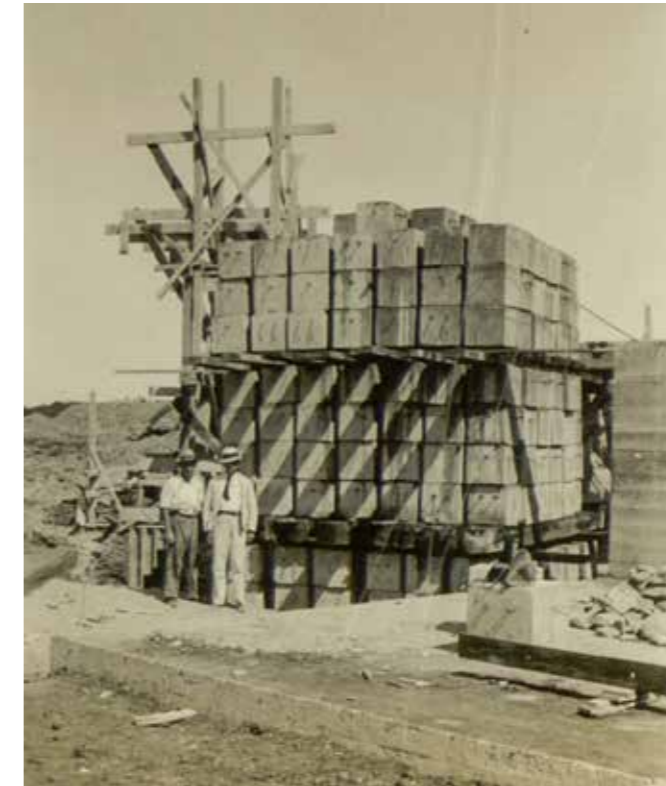
Εικ. 12. Δοκιμές αντοχής φόρτις πασσάλων (30 τόνοι ανά πάσσαλο) στον ρουφράκτη Κερκίνης.
