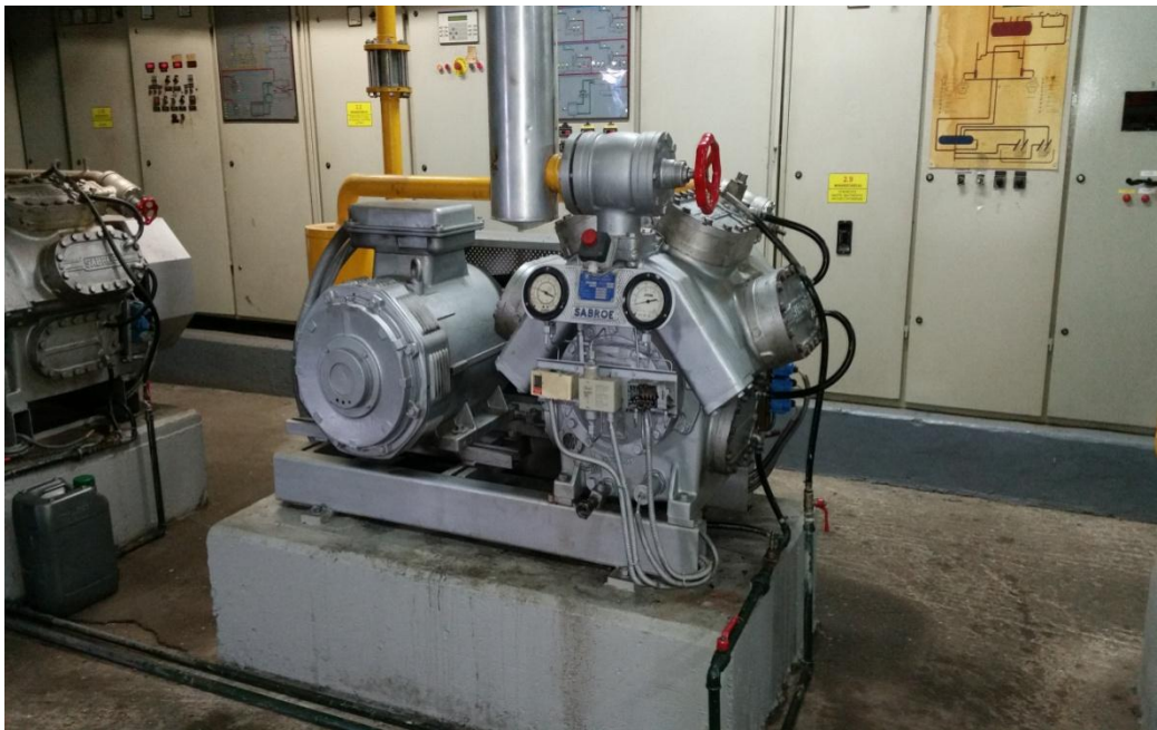
Εικόνα 7: Ανοικτό τύπου παλινδρομικός συμπιεστής συνδεδεμένος παράλληλα με τον ηλεκτροκινητήρα (σύνδεση με σύστημα τροχαλιών-ιμάντων)
