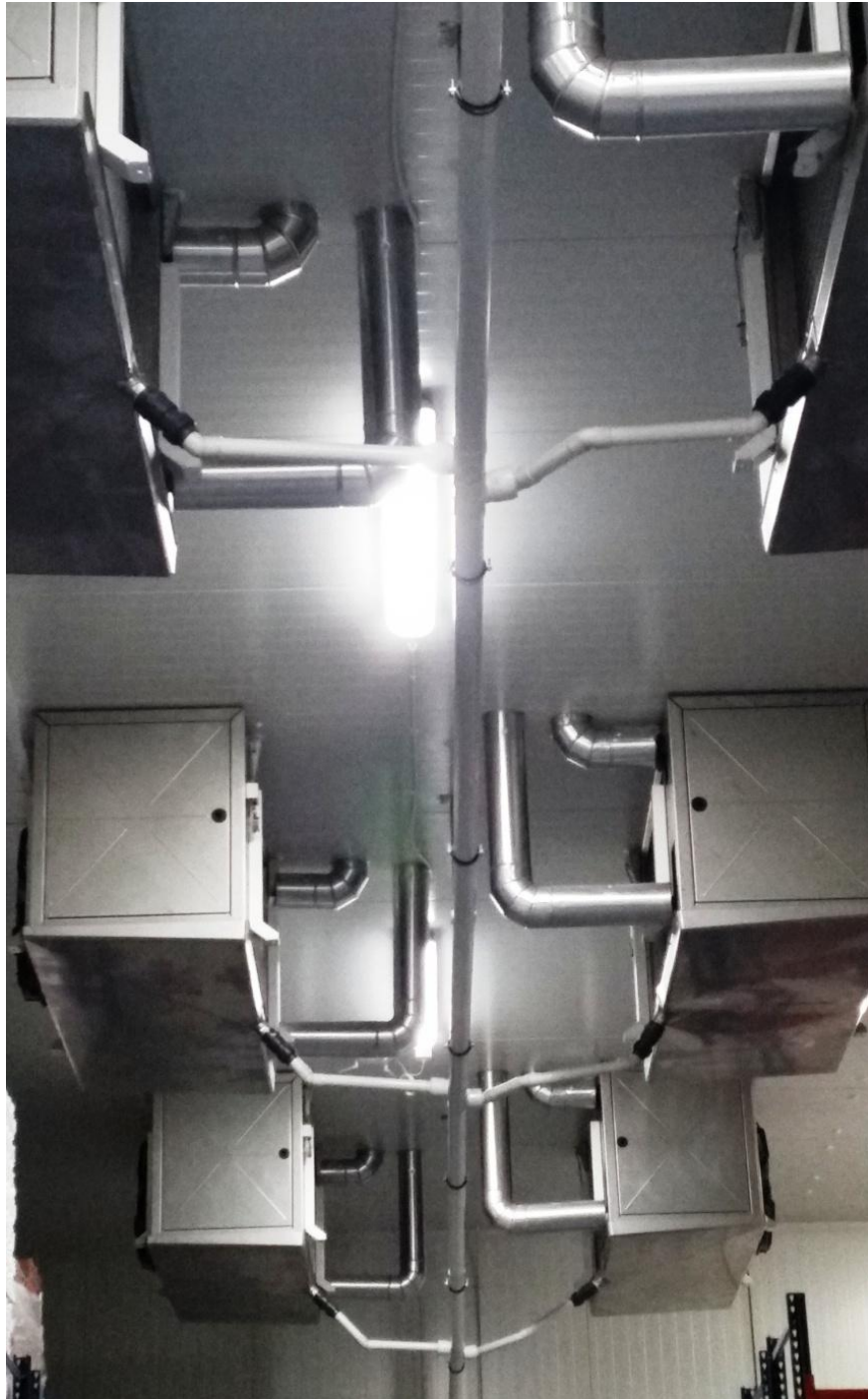
Εικόνα 51: Διάταξη ψυκτών αέρα για την ψύξη προϊόντων
