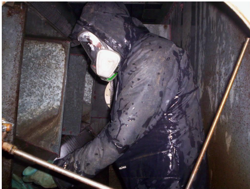
Εικόνα 40: Χημικός καθαρισμός εξατμιστικού συμπυκνωτή
