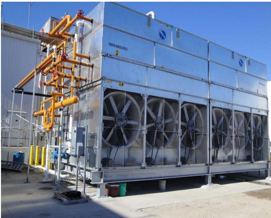
Εικόνα 38: Εξατμιστικός συμπυκνωτής R717 Αμμονία (με το χαρακτηριστικό κίτρινο χρώμα στο δίκτυο σωληνώσεων)
