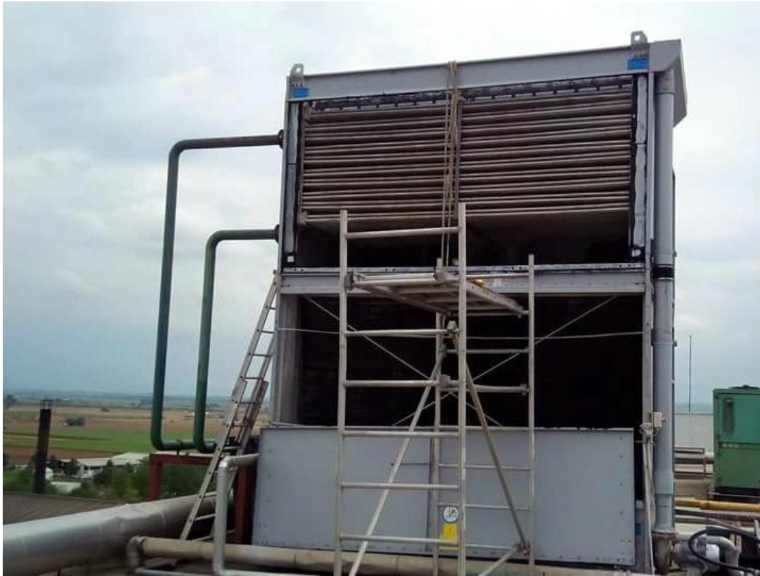
Εικόνα 41: Πύργος ψύξης νερού κατά την διάρκεια συντήρησης.
