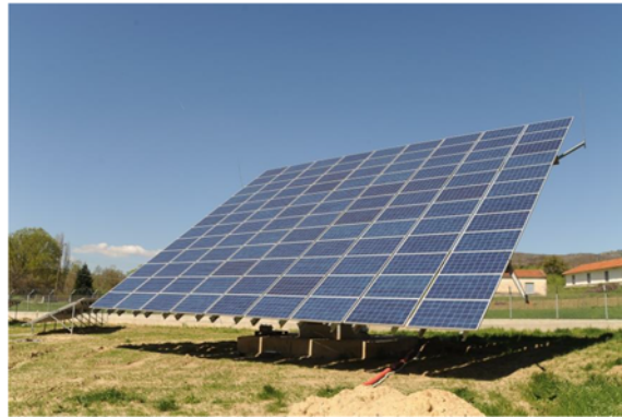
Εικόνα 2.3 Φ/β σύστημα με κινητήρα για την παρακολούθηση του ηλίου.
